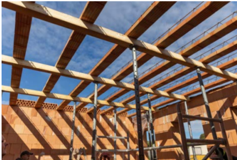
Obrázek č. 5 – Podepření stropu Porotherm [3]
