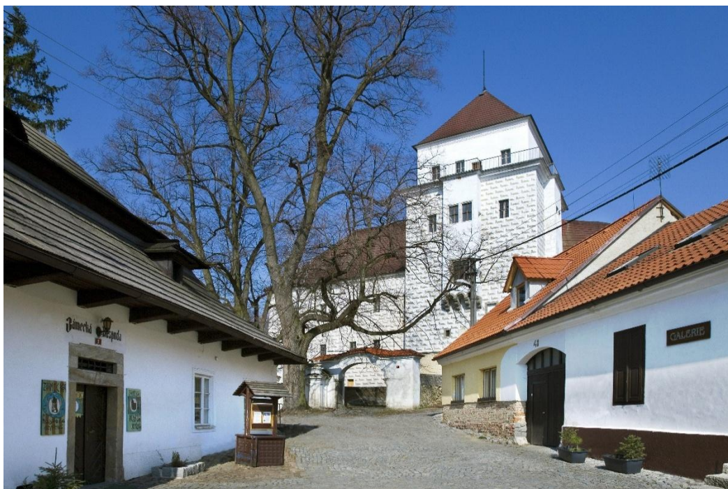
Obr. 14: Pohľad na vstup do zámku z ulice Ing. Lízla 28
