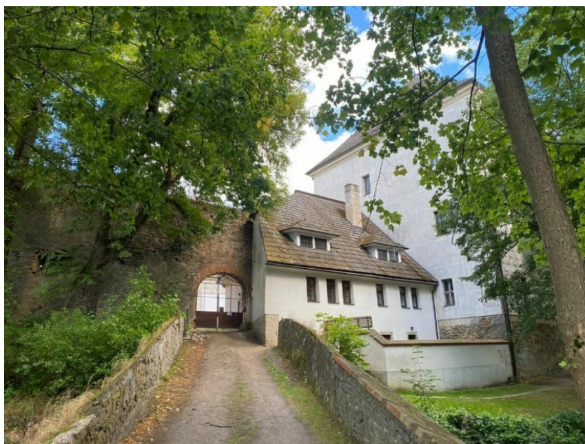
Obr. 17: Pohľad na bočný vstup z vonkajšej strany 31
