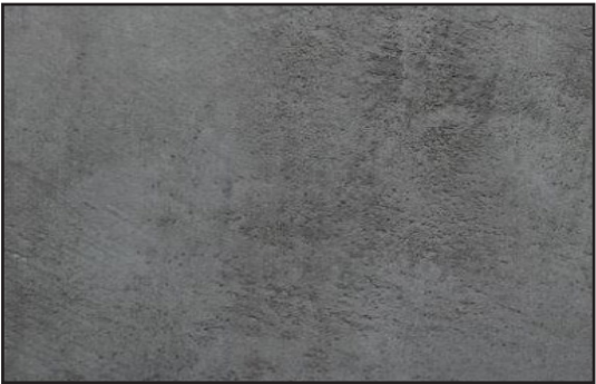
STĚNA pohledový železobeton s bezbarvým penetračním nátěrem
