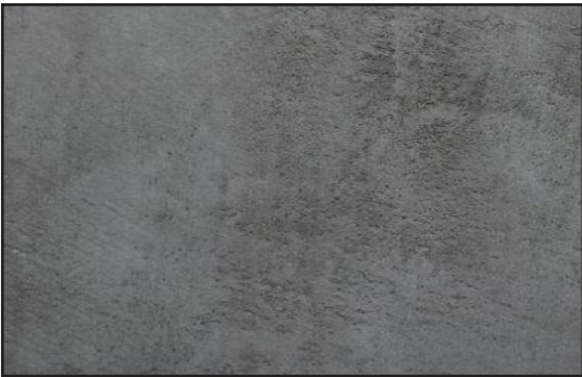
STĚNA pohledový železobeton s bezbarvým penetračním nátěrem
