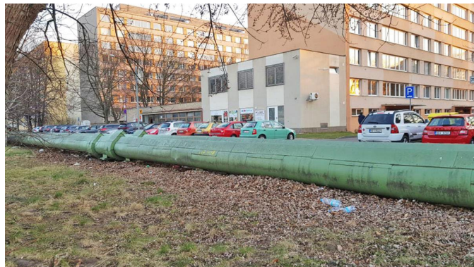
Obr. č.2: nadzemní teplovod na sídlišti v Chrudimy
