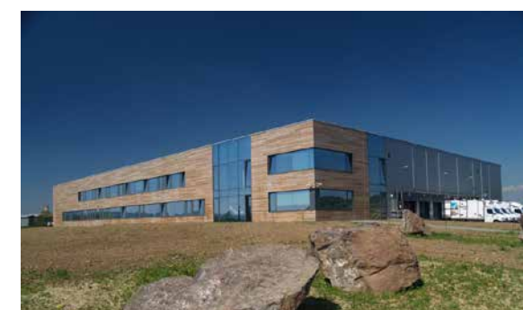
Obr. č.100: moderní budova Pekařství Sázava
