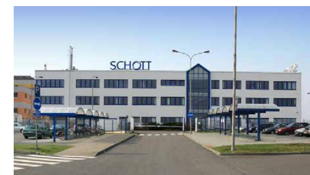
Obr. č.101: zázemí firmy SCHOTT CR, s. r. o.
