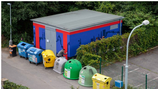
Obr. č.1: trafostanice s pozemními odpadovými nádobami
