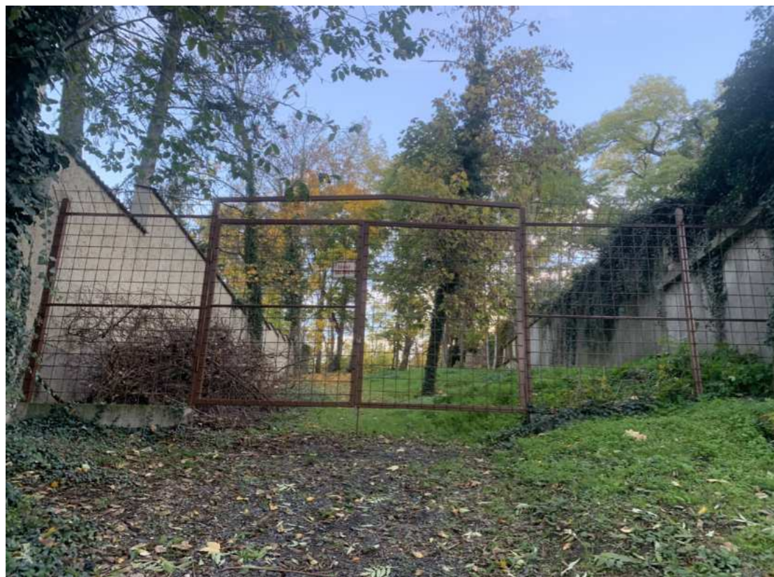
stávající vstup z ulice Wolkerova
