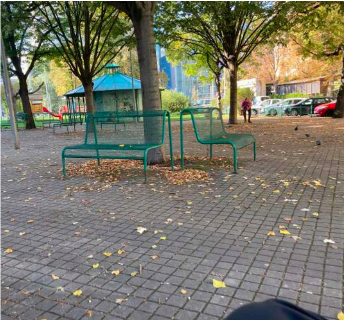
obr.: 09. Středová třetina, vydlážděna betonovou zámkovou dlažbou
