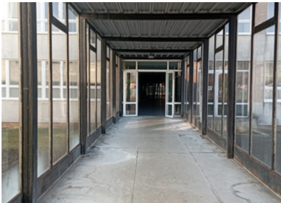
prepojenie telocvične a budovy ZŠ
