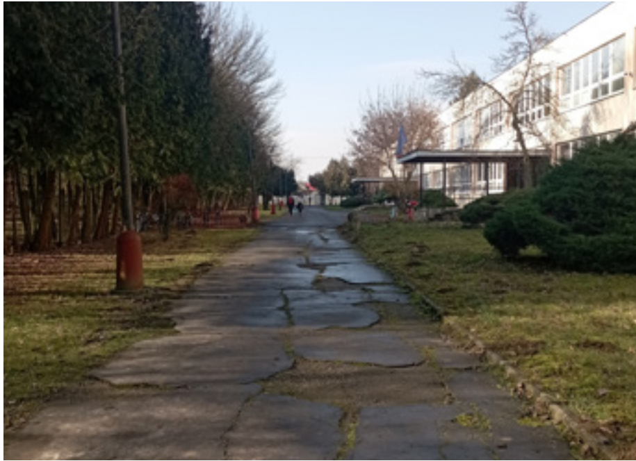
nádvorie pred vstupmi do objektu ZŠ
