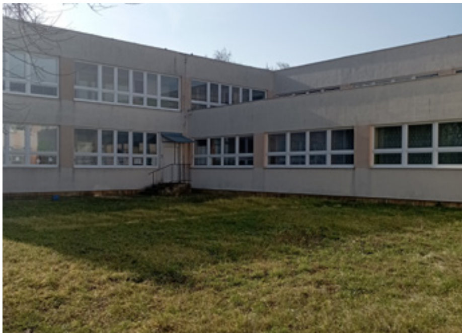
nádvorie na východnej strane
