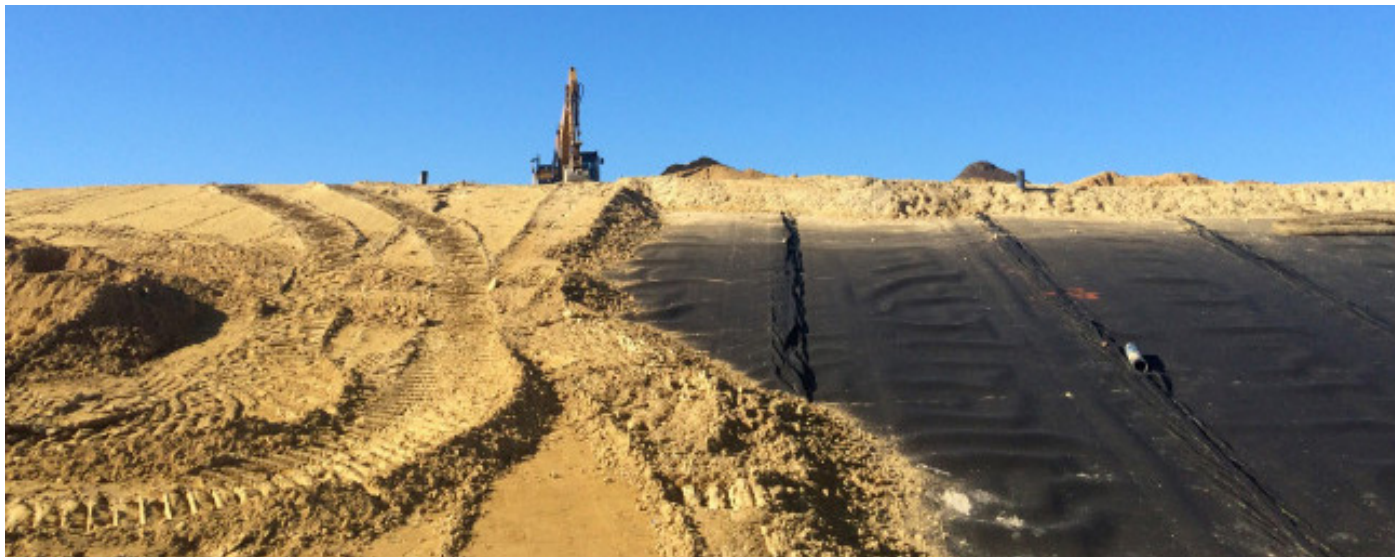
Obr. 11 - Pokládání ochranné vrstvy zeminy na drenážní vrstvu a hydroizolační folii (Michael Anton, 2008)
