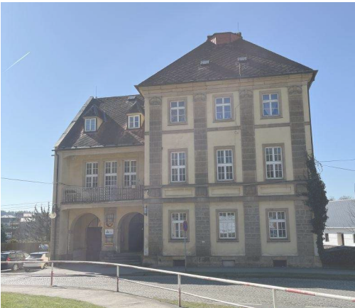
budova pošty naproti řešenému místu
