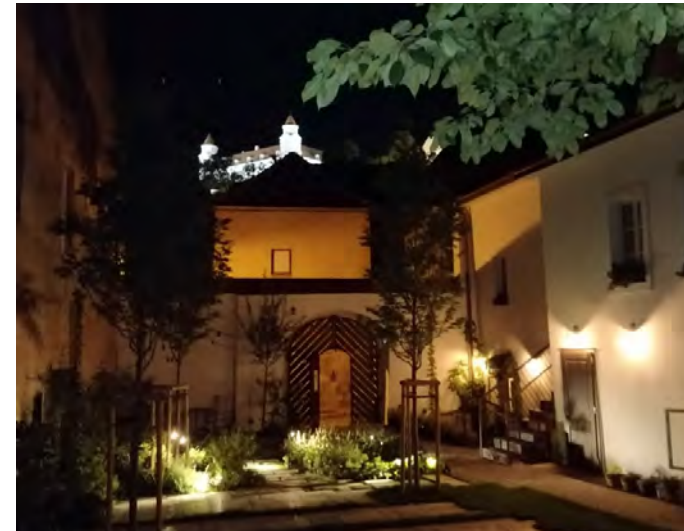
teplý tón osvetlenia osvetlenie fasády domu a záhonov
