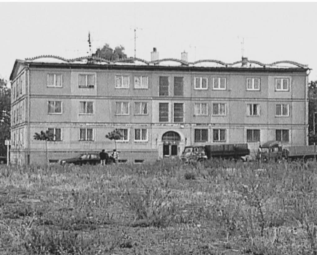
První panelový dům v ČSR, Praha, Ďáblice se posadil dle návrhu architekta M. Wimmera, který podal návrh v roce 1948. Nešlo ještě však o typizovanou stavbu, nýbrž jen použití prefabrikovaných prvků, byla zde použita skeletopanelová konstrukce a dům.
