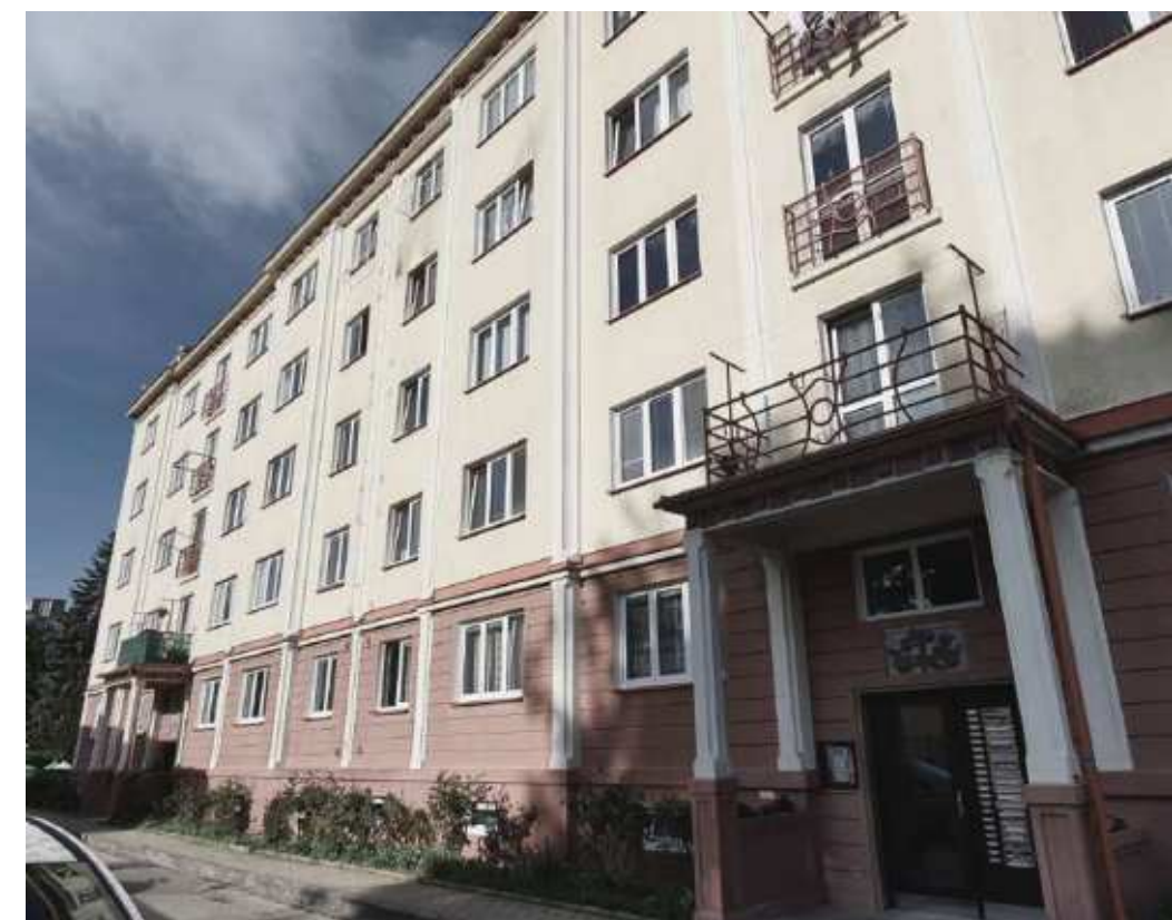
Návrh domu se ještě nesů ve vlivu socialistického realismu. Jelikož byl dokončen o rok dříve než panelový dům v pražských Ďáblicích, je někdy považován za první panelový dům v ČSR.
