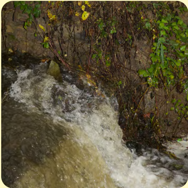
Vinořský potok vtékající do zatrubnění
