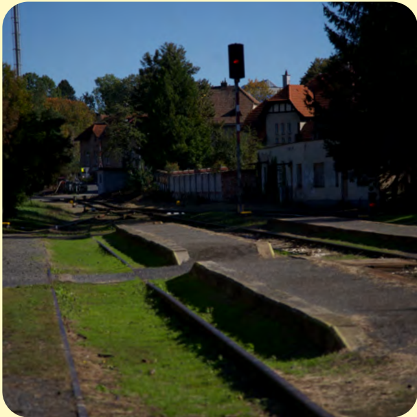
Nádraží v roce 2021 před započítím výstavby.
