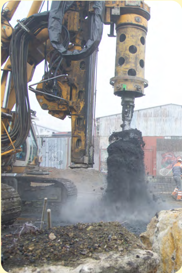
Výstavba parkovacího domu v roce 2022.
