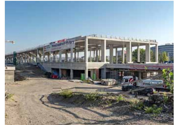
Pohled na stanici Praha-Bubny z prostoru budoucí Vltavské filharmonie
