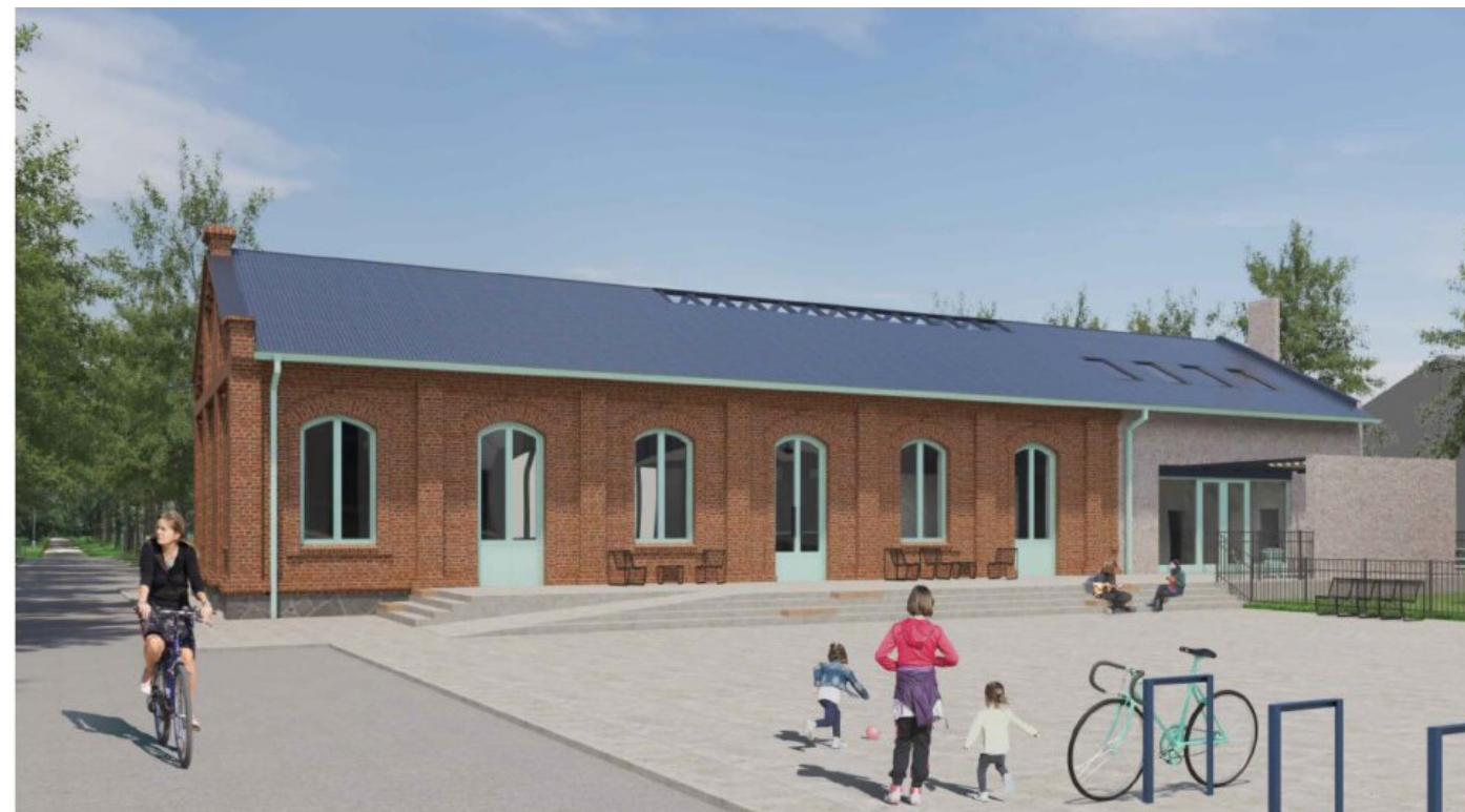
Obr. č. 10 – exteriér komunitní centrum Berdiška
