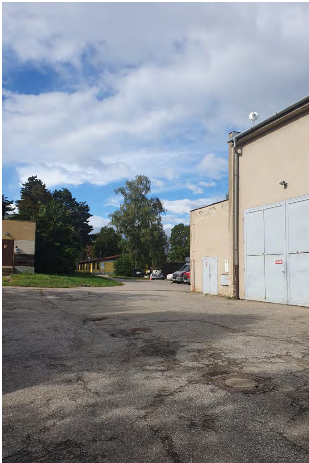
fotografie 73 — Technologický objekt v areálu kasáren, 2024
