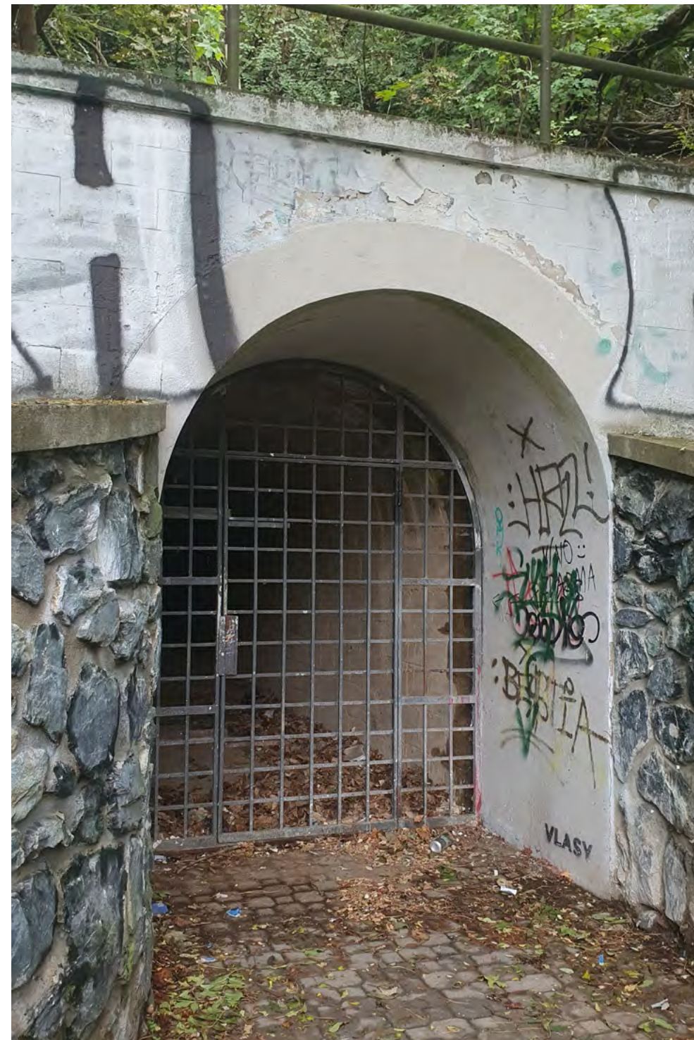
fotografie 96 — Vstup do protileteckého krytu od ulice Úvoz, 2024
