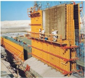
VARIO GT 24 na stavbě čistírky u stěn kónického tvaru.
