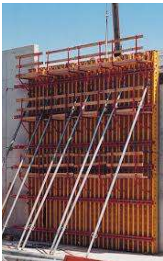
Príloha D.5.1.3.3.3 – Obrázok zvoleného debnenia stien systémom VARIO GT24
