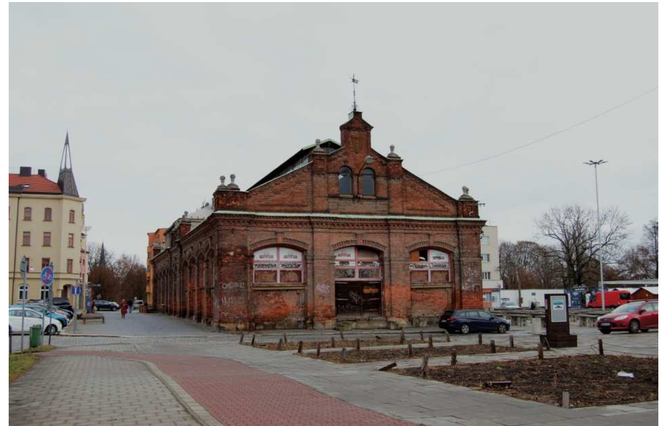
obr. 11: fotodokumentace tržnice v Olomouci
