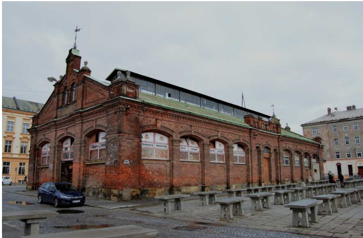
obr. 9: fotodokumentace tržnice v Olomouci
