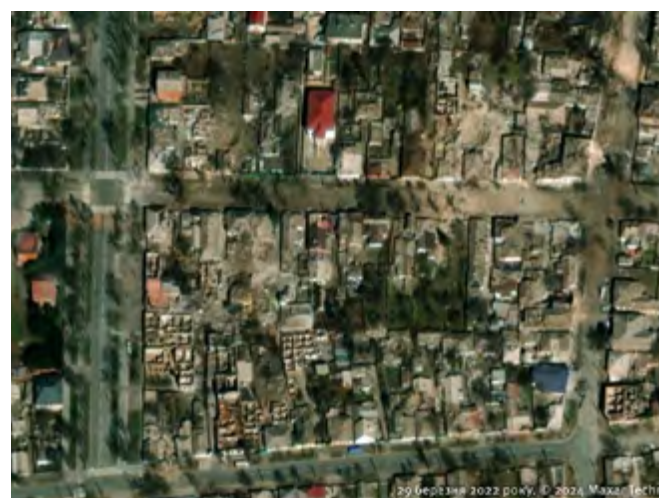
Obr. 91. Poškození jednopodlažních budov, 29. března 2022. © 2024 Maxar Technologies 2024
