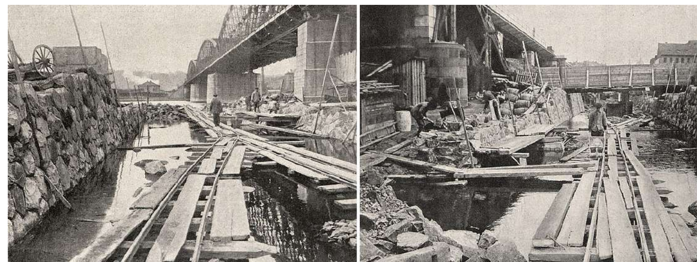
[6] zatrubňování ústí Botiče, 1904
