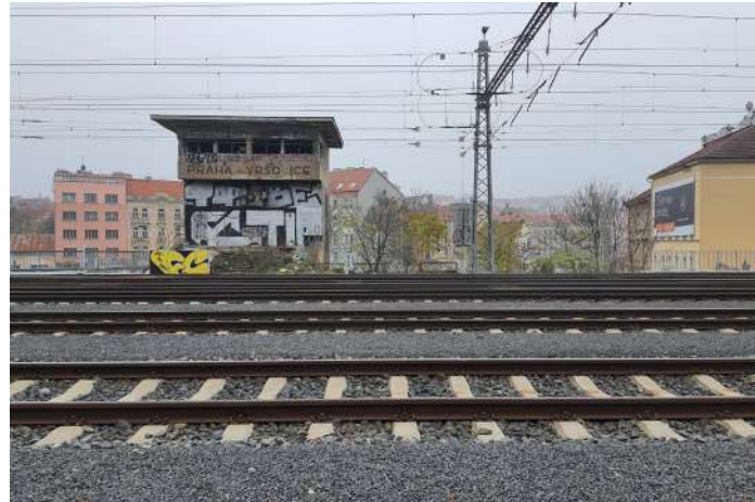
trať na železničním mostu
