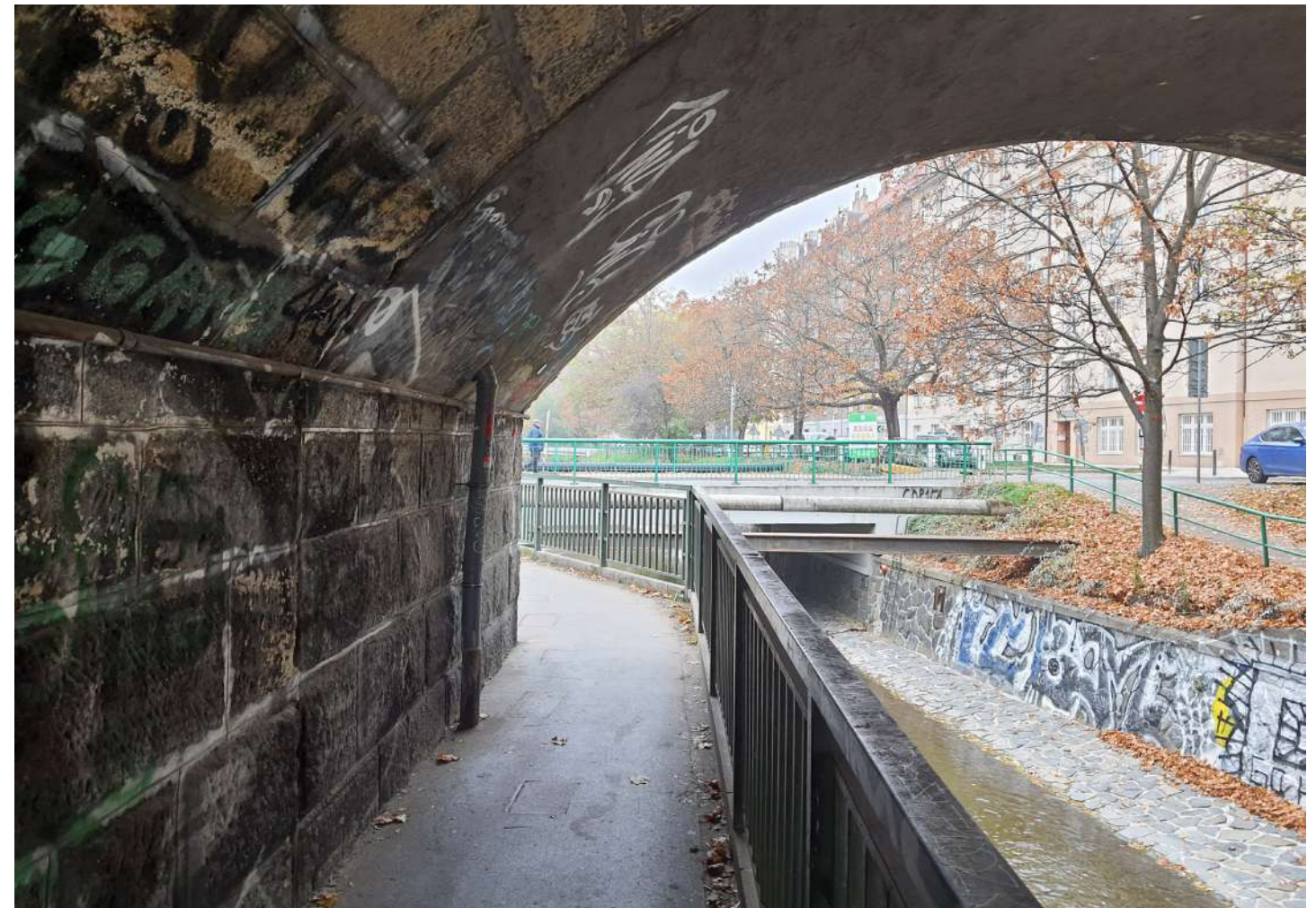
železniční most, Botič, Sekaninova
