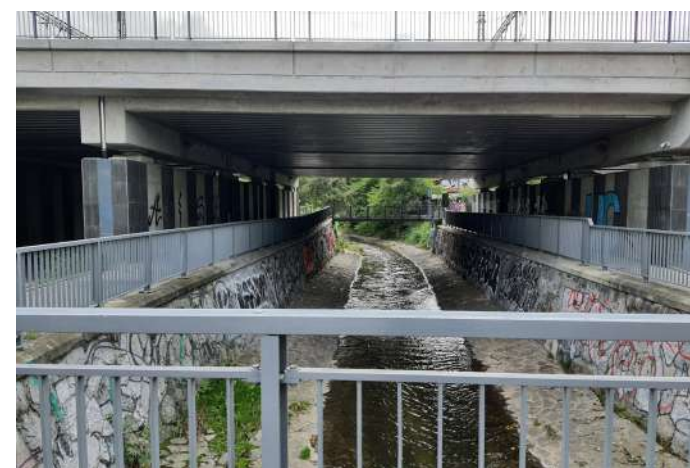
křížení Botiče a železniční trati, Vršovice
