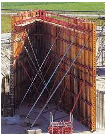
Nosníkové stěnové bednění VARIO
