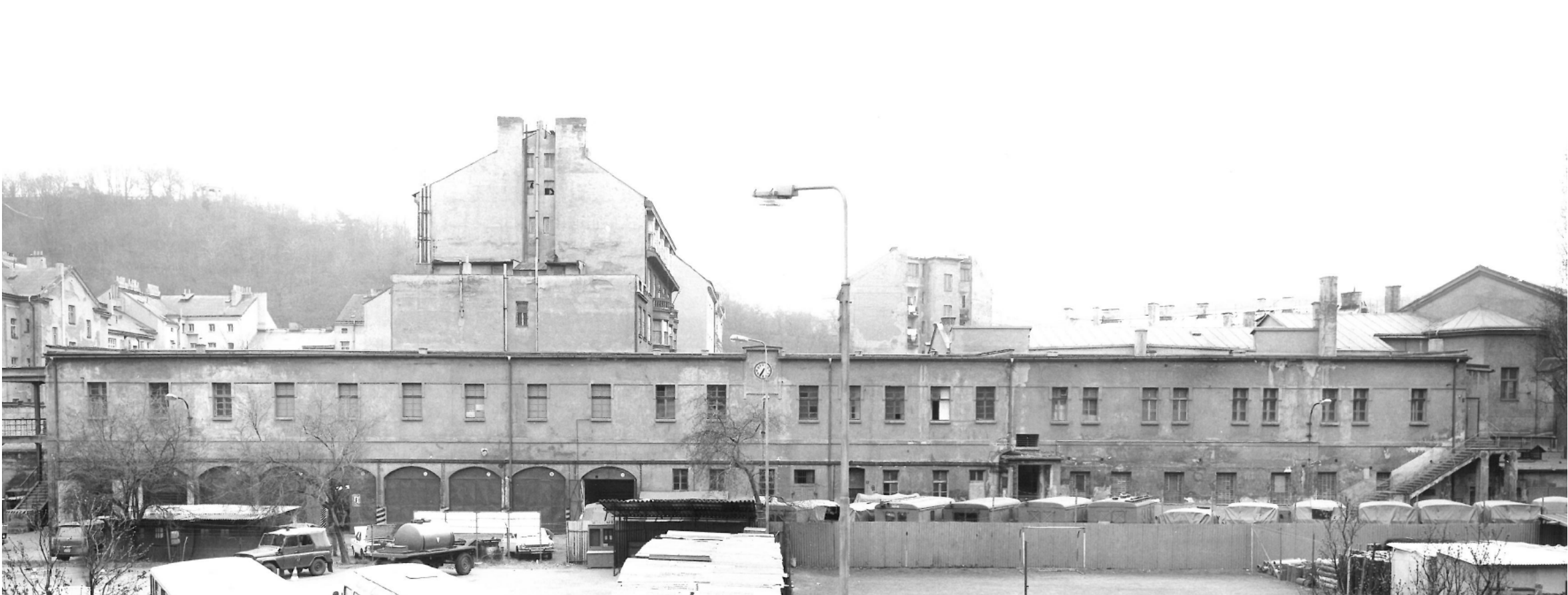
Dvorní objekt ze severního pohledu, 1989
