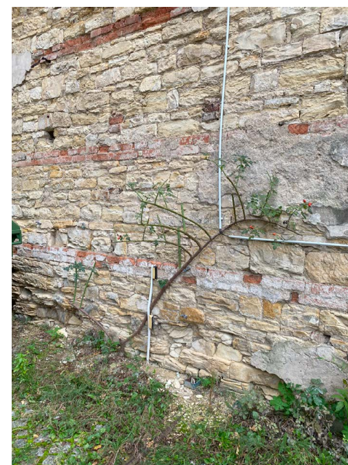
Původní kamenné zdivo z doby výstavby
