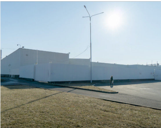
slepé fasády v místech zásobování OC
