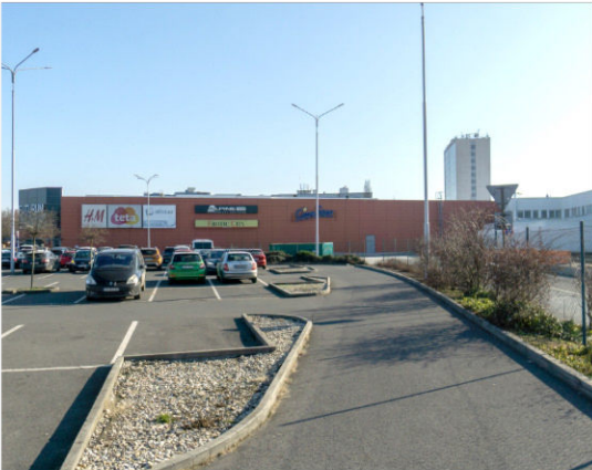
slepé fasády a parkoviště za objektem
