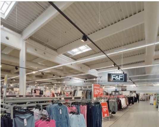
pohled na nosnou konstrukci objektu
