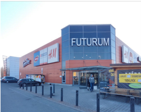
severní vstup z parkoviště
