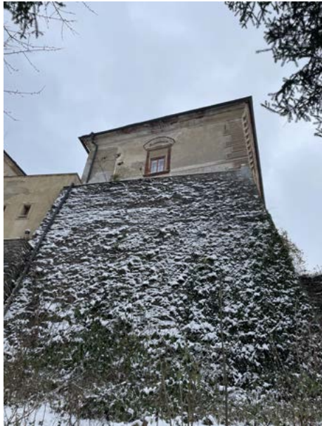
S fasáda zámku se založením na středo-věkem zdivu.
