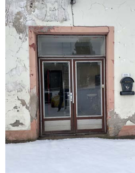
Detail okenních a dveřních otvorů v J fasádě S stodoly, zřejmě z přestavby ze 60. let nebo pozdější úpravy. Řešení neodpovídá výkresové dokumentaci. Budova je ve špatném stavebním stavu.
