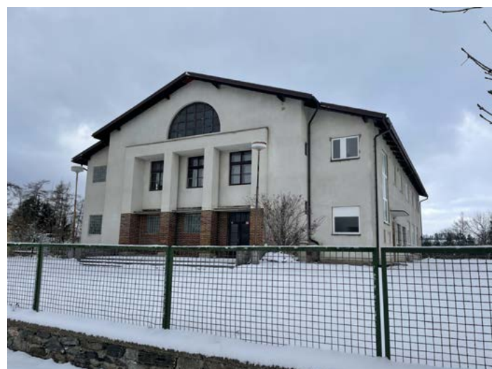
Sokolovna postavena ve V části prvního úseku bývalé barokní zahrady.
