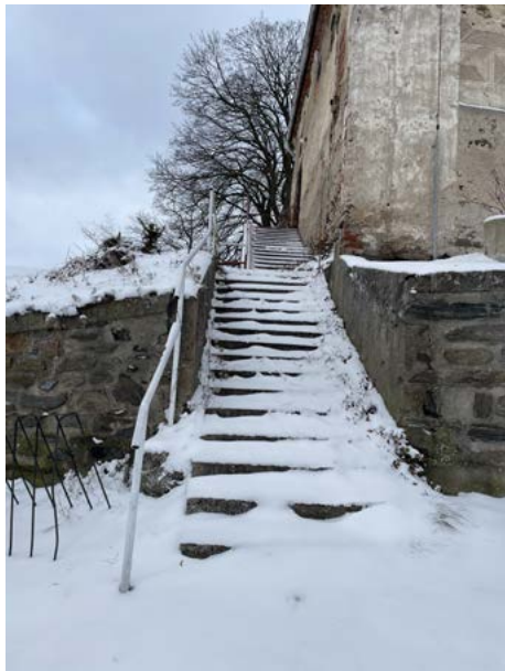
Trojramenné schodiště vedoucí k zadnímu vstupu do bývalého kina.
