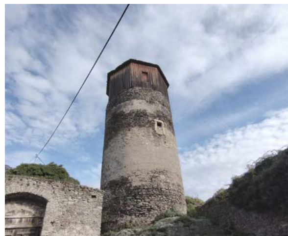
Bergfritová obranná věž u dolního hradu Pirkštejn, pohled na jižní stranu věže s gotickým portálem. (zdroj: vlastní snímek)
