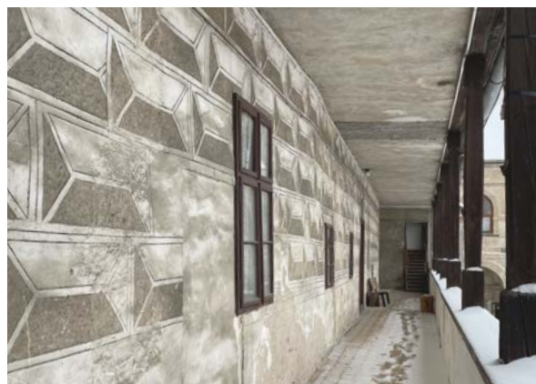
Zachovaná fasáda s psaníčkovým sgrafitem v patře jižního renesančního křídla (obnova z roku 1960). (zdroj: vlastní snímek)
