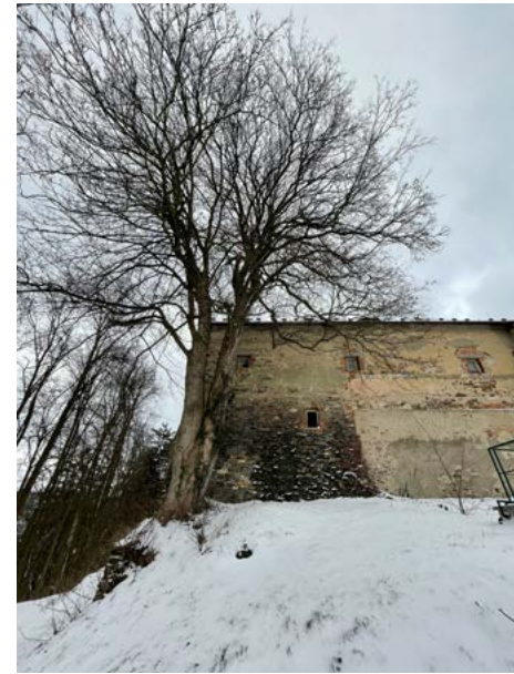
Z fasáda předzámčí, část budovy býva-lého kina.
