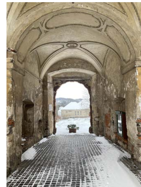
Průjezd od hlavní brány zámku do nádvoří na Z straně, podlaha průjezdu z dřevěných kostek.
