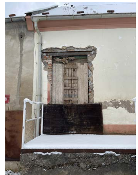
Otvor v J fasádě S stodoly, bet. terasa vyrovnávající odlišnou podlažnost.
