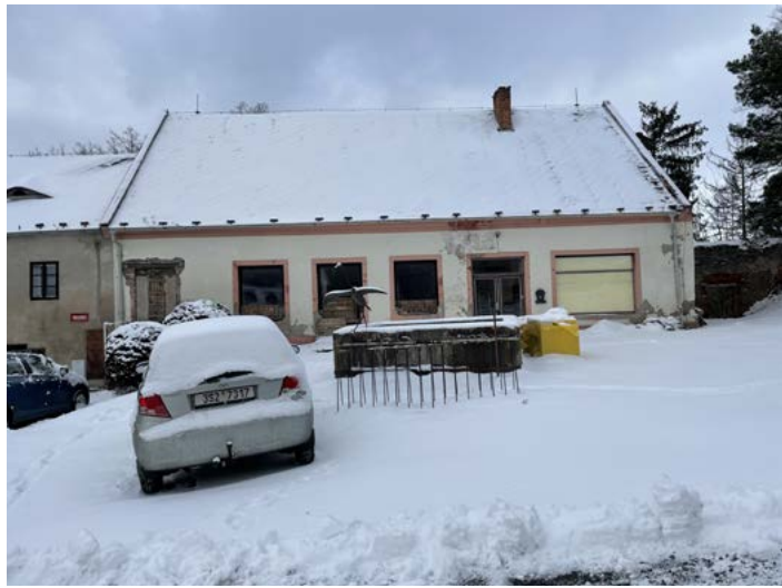
Celkový pohled na J fasádu severní stodoly předzámčí.
