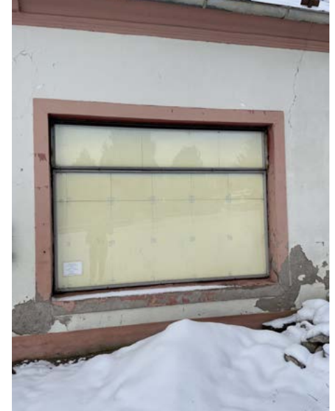
Detail okenních a dveřních otvorů v J fasádě S stodoly, zřejmě z přestavby ze 60. let nebo pozdější úpravy. Řešení neodpovídá výkresové dokumentaci. Budova je ve špatném stavebním stavu.
