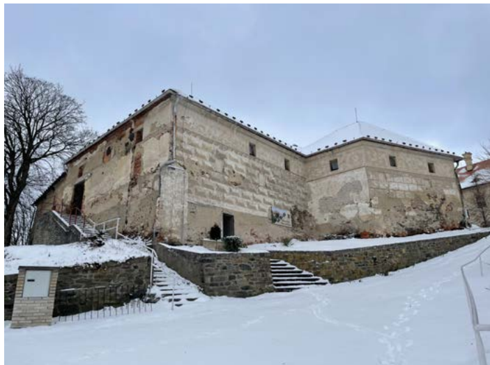
J fasáda předzámčí s přístupovými schodišti, foceno z hlavní přístupové cesty k zámku od historického jádra obce.
