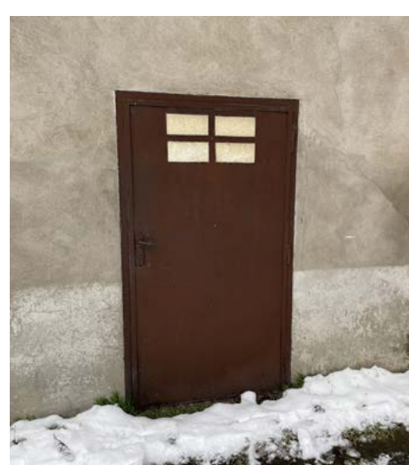
Detail kovových dveří na V fasádě objektu, v místě zazděného podloubí, možná bývalé kovárny.
