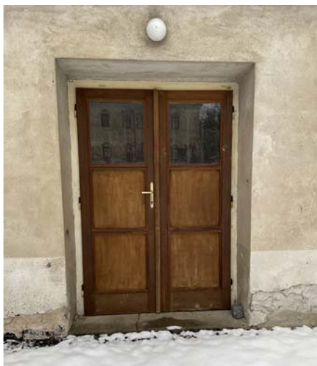
Detail hlavních vstupních dveří do bývalého kina na V fasádě.
