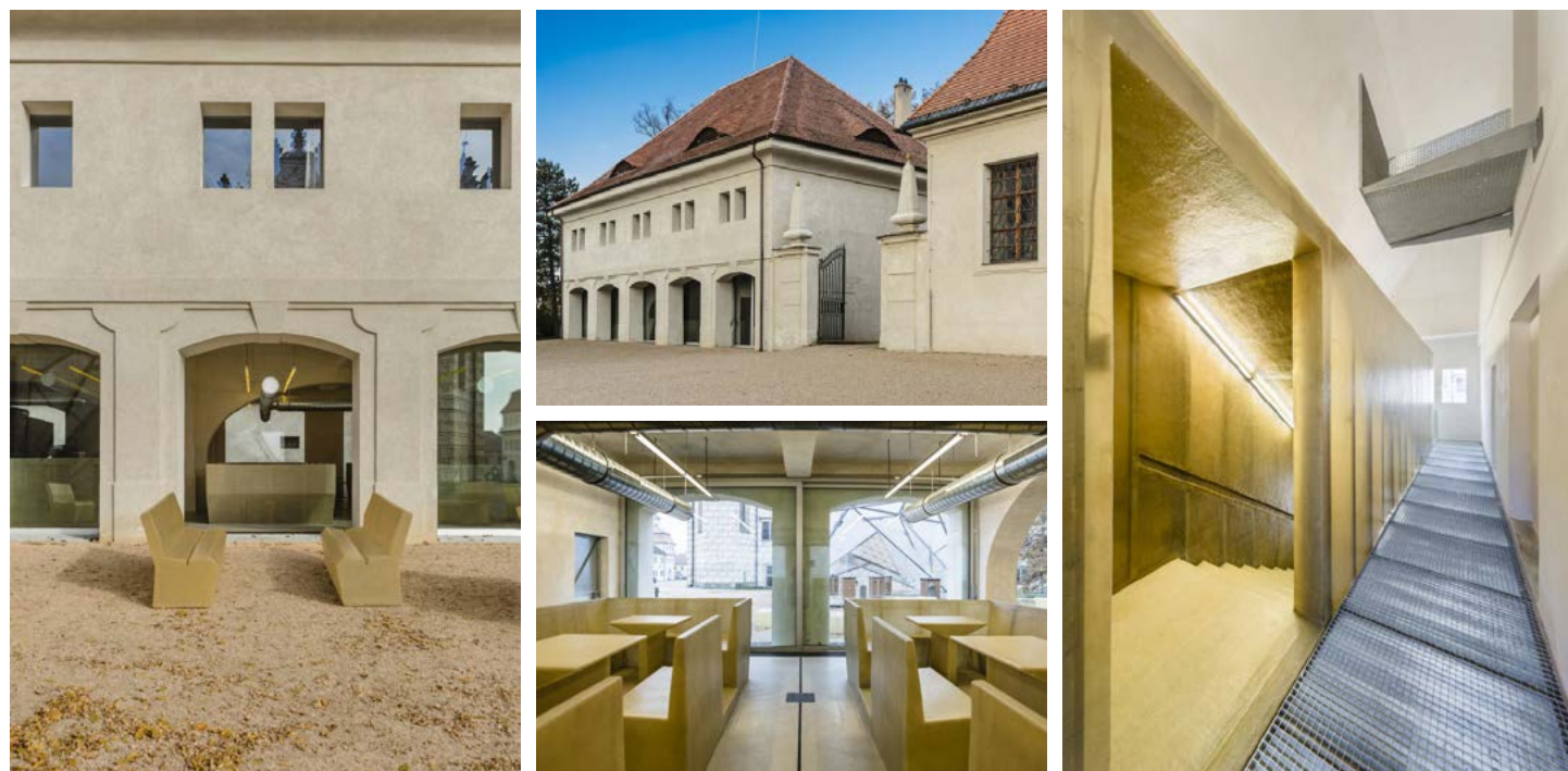
Rekonstrukce zámecké kočárovny - HŠH architekti - 2011/2014 - Litomyšl (zdroj: lam.litomysl.cz, 2024)
