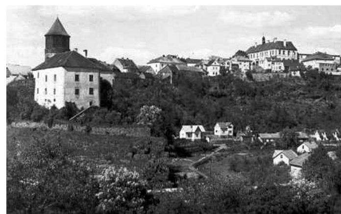
Pirkštejn (pohlednice z roku 1939)
