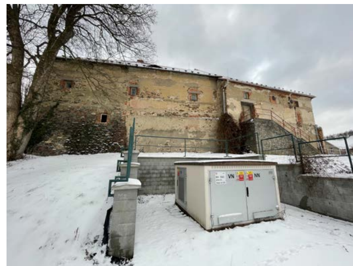
Z fasáda předzámčí s detailem na provedení elektroinstalační-ho zařízení, zadní část areálu.
