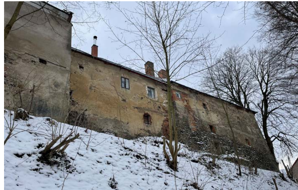
S strana SZ křídla předzámčí s patrem, v Z části došlo v 60. letech k přestavbě ob-jektu na kinosál.
