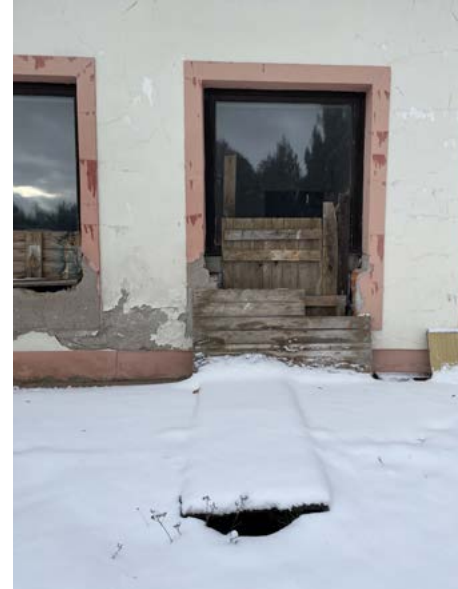
Detail okenních a dveřních otvorů v J fasádě S stodoly, zřejmě z přestavby ze 60. let nebo pozdější úpravy. Řešení neodpovídá výkresové dokumentaci. Budova je ve špatném stavebním stavu.
