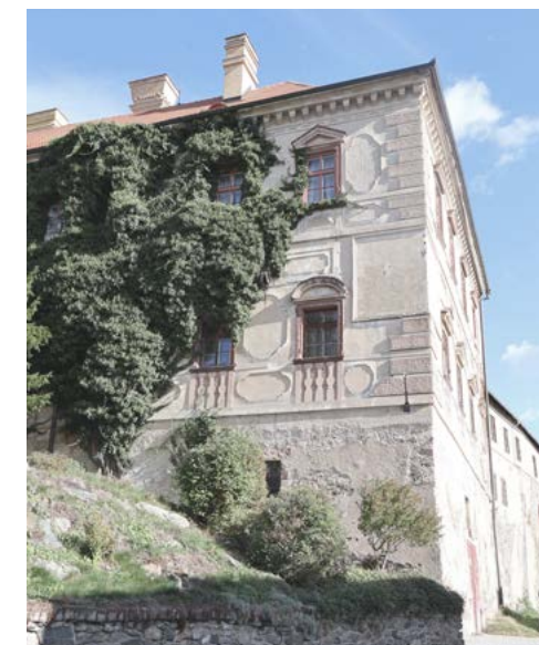
Severní křídlo s plastickým členěním fasády. (zdroj: vlastní fotografie)
