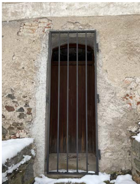
Detail na dveře s kovovou mříží v J fasádě předzámčí, vedoucí do sklepa.
