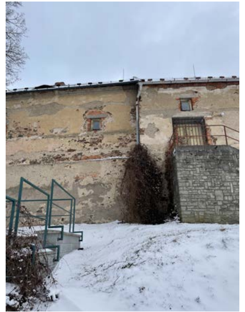
Detail na styk zdiva dvou původně od-dělených hospodářských objektů, později spojené a předělané na kinosál.
