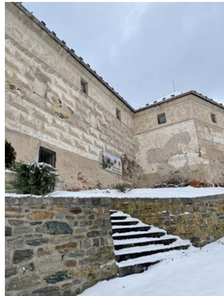
J vstup do sklepních prostorů předzámčí, fasáda zdobena renesančním sgrafitem.
