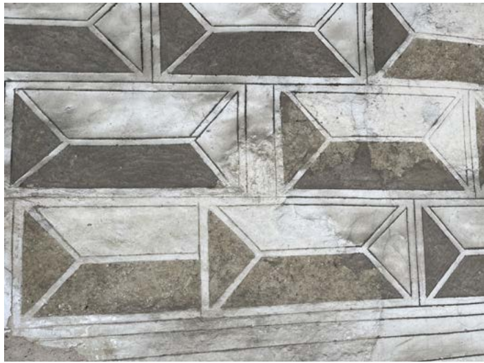
Detail sgrafita na dvorní fasádě J křídla zámku.
