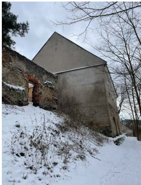
V štít severní stodoly předzámčí a nez-pevněný přístup na S svah a turistickou trasu skrze předzámčí.
