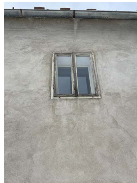
Detail špaletového okna na J fasádě v patře předzámčí.
