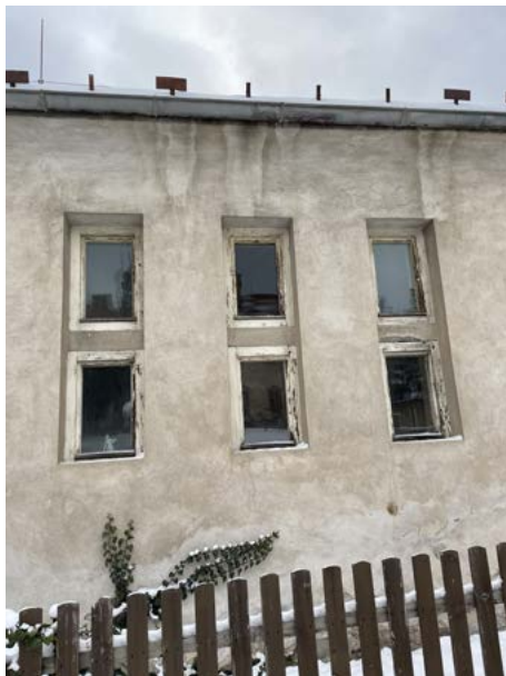
Detail okenních otvorů na V fasádě z přestavby v 60. letech.
