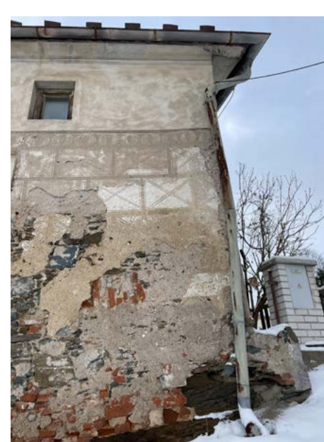
Detail sgrafita na J fasádě V objektu a jeho nároží.
