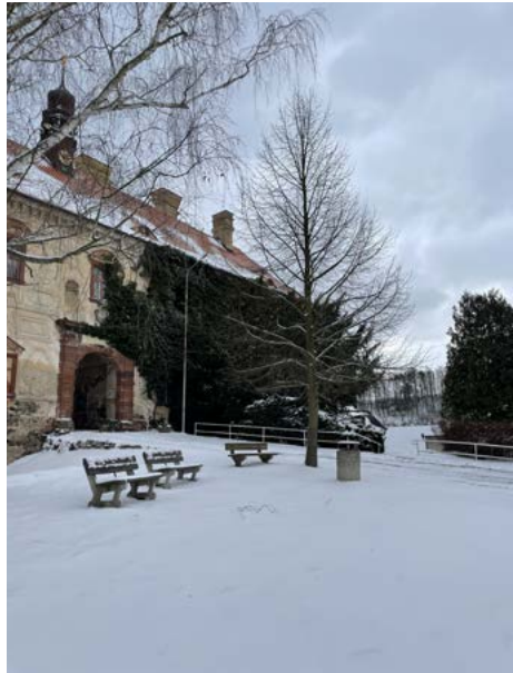
Pohled na Z fasádu zámku a rozmístění mobiliáře v areálu předzámčí.
