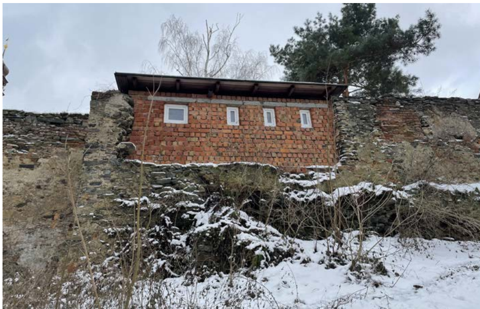
Pohled na zadní S stranu novostavby veřejných záchodků, stavba zasazena do zámeckého opevnění.
