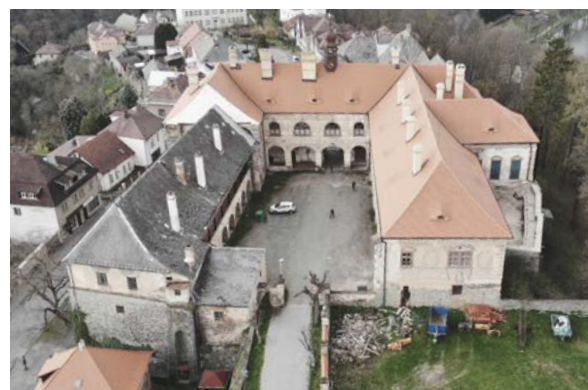
Letecký snímek současného stavu zámku - pohled na nedokončené východní křídlo. (zdroj: mapy.cz, foto: Miroslav H., 7.4.2019)
