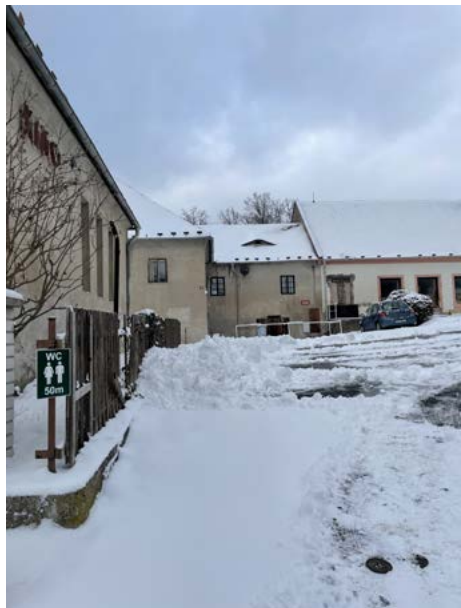
Pohled na J fasádu předzámčí.
