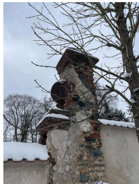
Detail obvodové zdi Z úseku barokní zahrady, která je ve velké míře zachovaná.
