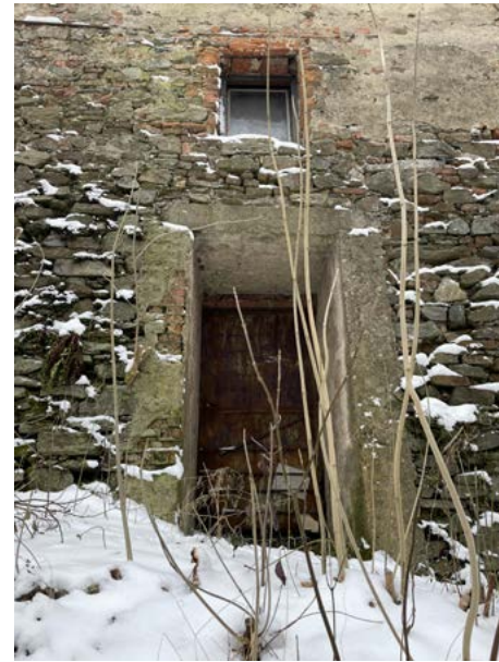
Dveře do sklepa v S fasádě předzámčí, vstup vede do bývalé kotelny.
