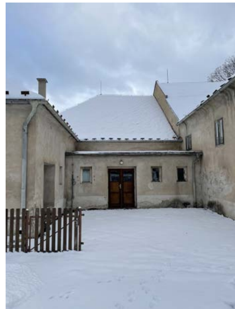
Hlavní vstup do bývalého kina, uprostřed vestavba ze 60. let propojující hospodářské objekty.
