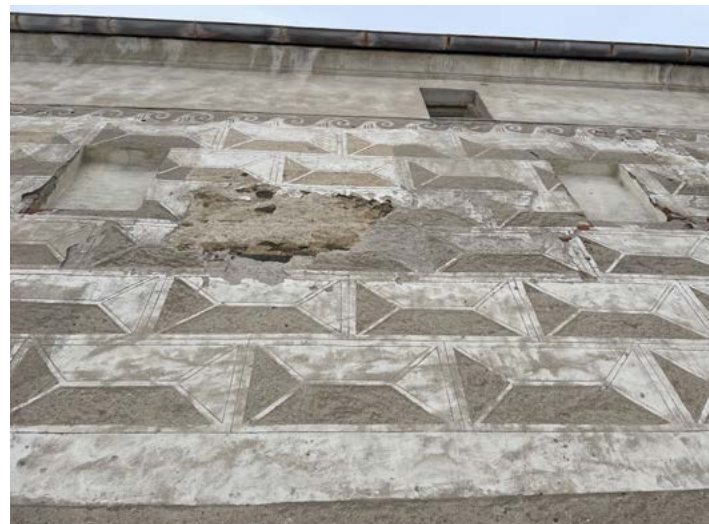
Detail dochovaného sgrafita na J fasádě Z objektu s detailem na původní okenní otvory zazděné při přestavbě v 60. letech,
