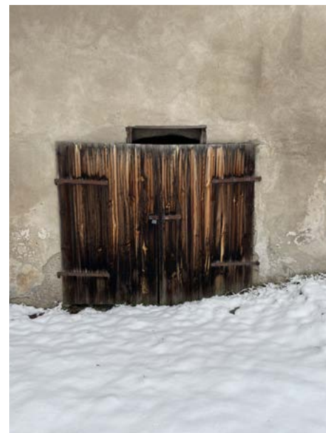
Detail dveřního otvoru v J fasádě, částečně pod terénem, poukazuje na odlišnou podlažnost budov předzámčí.
