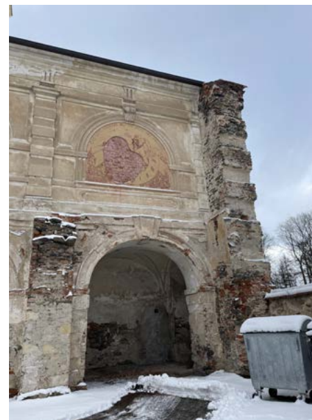
Sluneční hodiny na J fasádě S křídla Zámku s viditelným „šmorcem“ pro nikdy nerealizované napojení Z zdiva.
