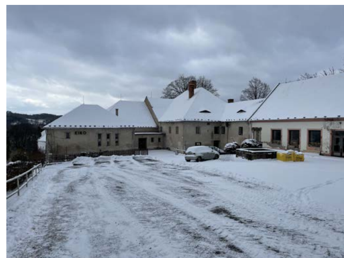
Pohled na V a J fasádu předzámčí, směrem od zámku, povrch nádvoří tvořen směsí betonu a travnatých úseků.
