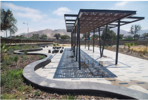
PARQUE KAUKARI Copiapó, Chile, 2014 Teodoro Fernández Arquitectos Foto: Rodrigo Opazo (Obr. 74)
