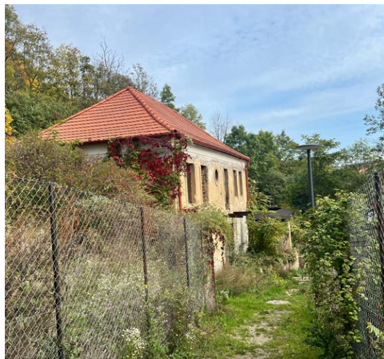
- stabilizovaná budova č. 145 s novým krovom
