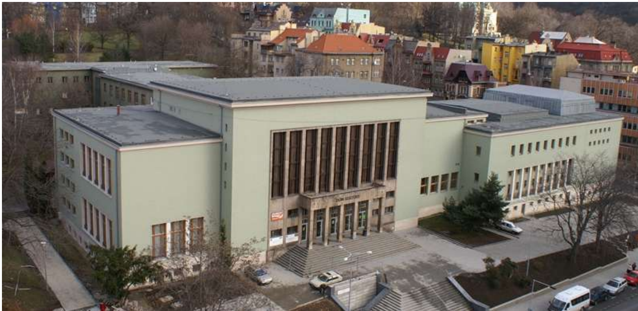
Dům kultury Ústí nad Labem
