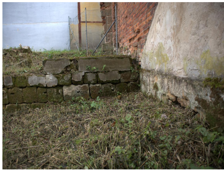
Foto - Kamenná zídka u malého skleníku kolmo k západnímu pavilonu Knappová 2025
