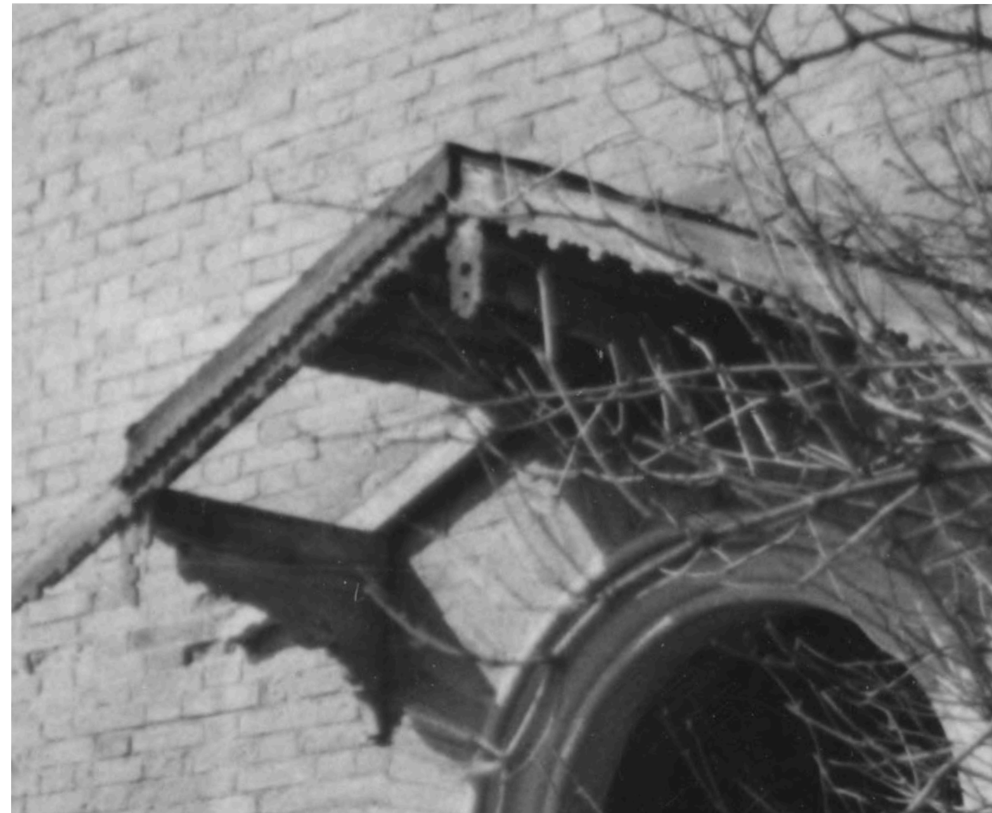
Detail stříšky nad vstupním pavilonem - ještě zachovalý, zdoj: NPU foto 1991
