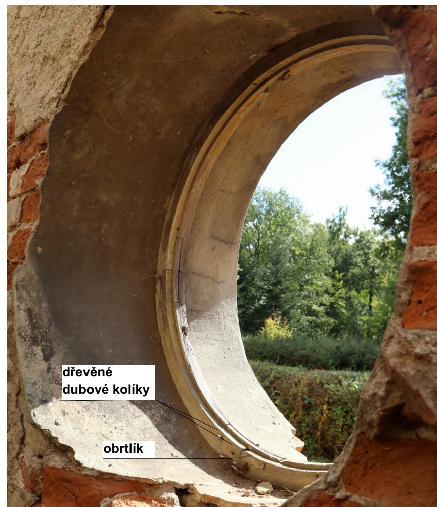
Foto kulatého okenního rámu ve stěně velkého skleníku
