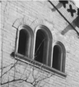
01, foto ostění trojkna, vstupní pavilon čelní stěny, 1991
