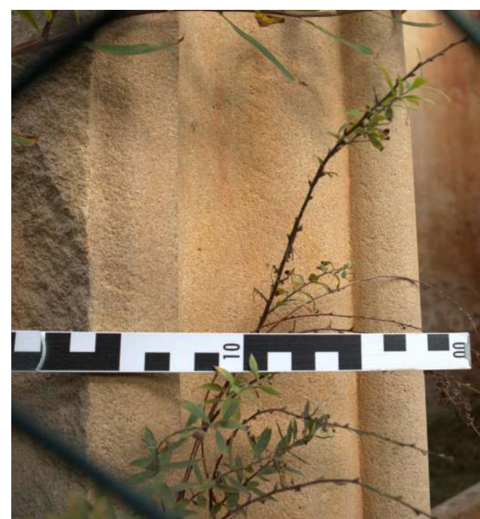
Detail kamenného ostění kruhového okna, zdoj: Autorské foto,2024
