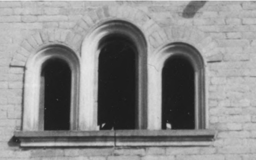
01, foto ostění trojkna, vstupní pavilon čelní stěny, 1991
