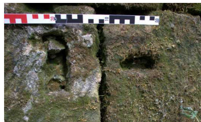
Detaily stop po nosné konstrukci skleníku tvaru A, autorské foto 2024
