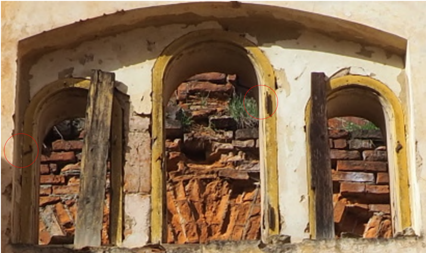
Foto, Trojokno s dochovalými rámy s chybějícími okenními křídly, Tregl 2023
