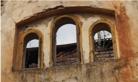
04, foto dochovalého rámu trojkna, vstupní pravý pavilon vnitřní stěna, 2023
