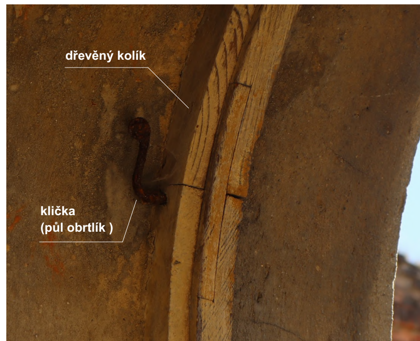
Foto kulatého okenního rámu ve stěně velkého skleníku
