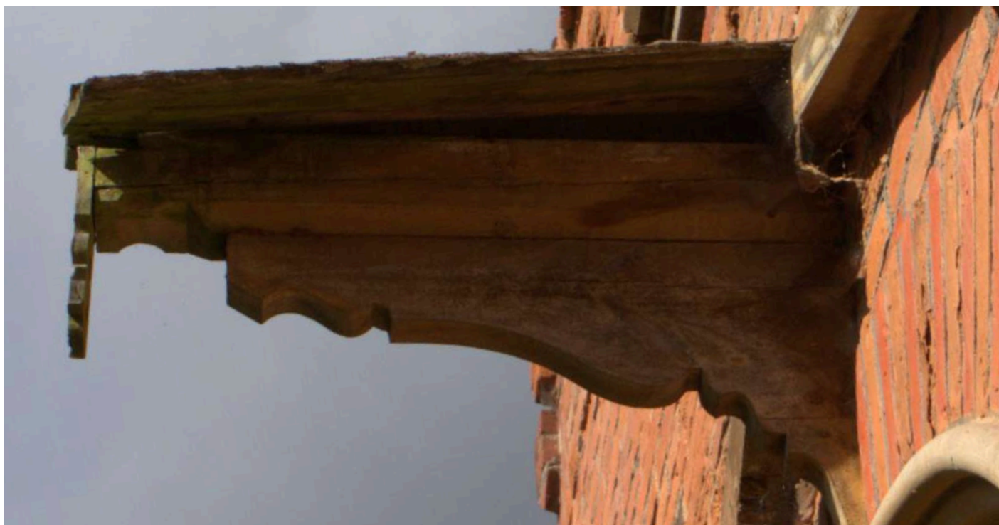
Detail dekoru na stříšce u vstupního pavilonu stav k 9. 2024, zdoj: Autorské foto,2024
