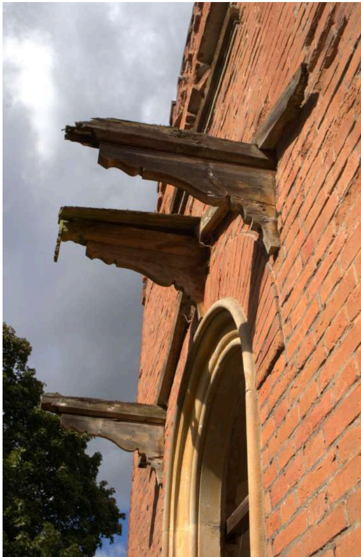
zdoj: NPU foto, Stříška nad vstupním pavilonem - stav k 9. 2024
