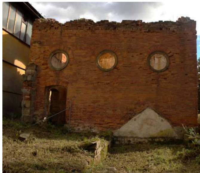
Pavilon směrem na východ, omítkový otisk skleníku tvaru A, autorské foto 2024
