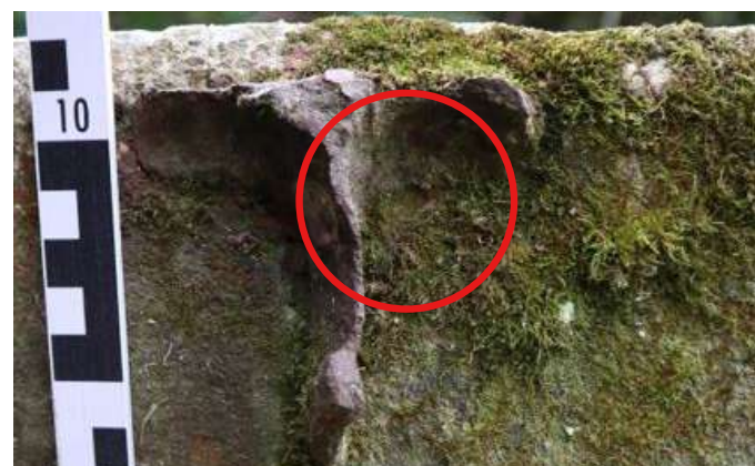
Detaily stop po nosné konstrukci skleníku tvaru A, zdroj: autorské foto 2024, autorské foto 2024
