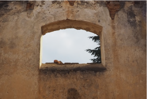
03, foto čelní okno vnitřní pohled, vstupní pavilon, 2023
