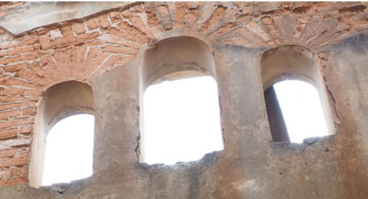
05, foto ostění trojkna, vstupní pavilon čelní stěny,
