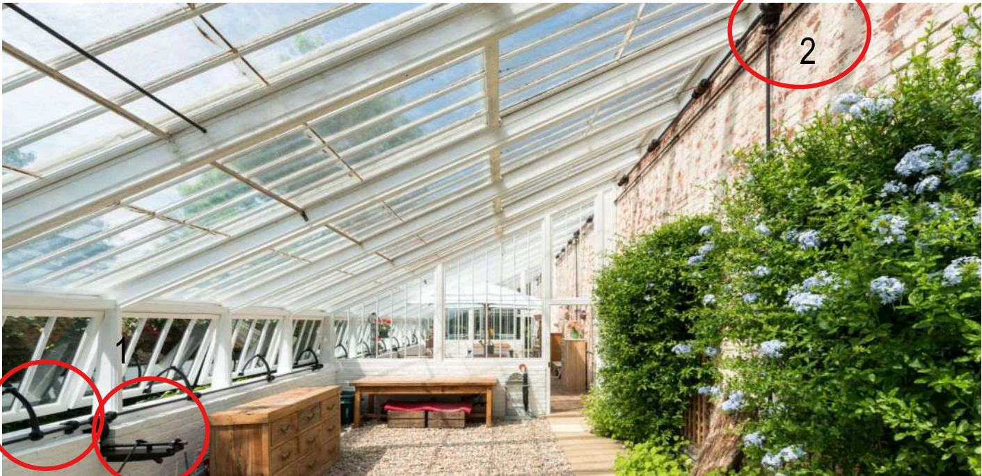
1- systém jendnotného otevírání oken 2 - vnitřní stínění a mechnizmus k spouštění, foto: anglie skleníky
