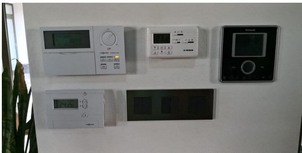
Obr. 28: Zed' plná ovládacích panelů
