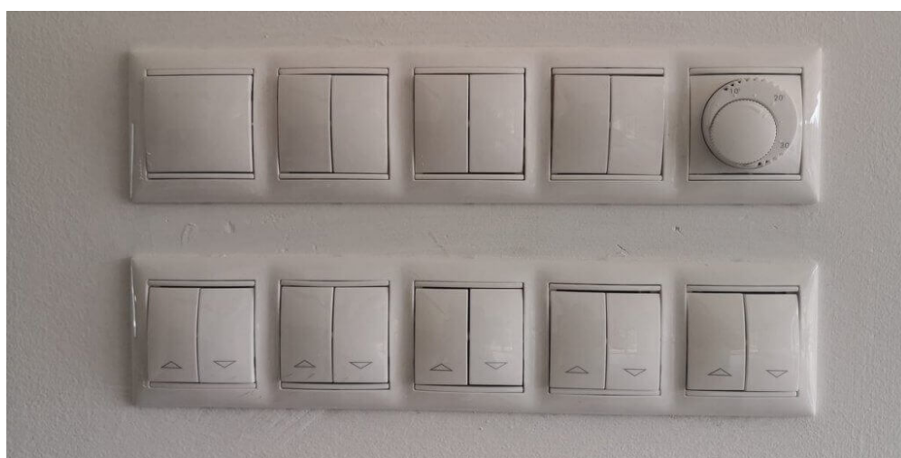
Obr. 29: Zed' plná ovládacích panelů
