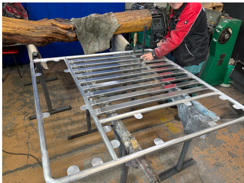
Obr. 41: Hotový rám před povrchovou úpravou
