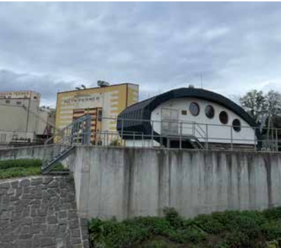
Vodní elektrárna Svijany
