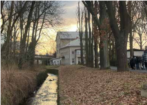
Vodní elektrárna v Turnově - „Šořalý mlýn“
