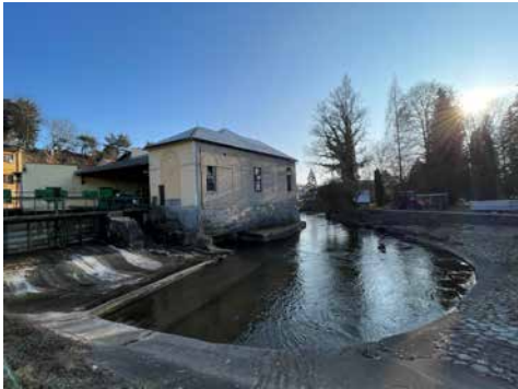
Vodní elektrárna Turnov
