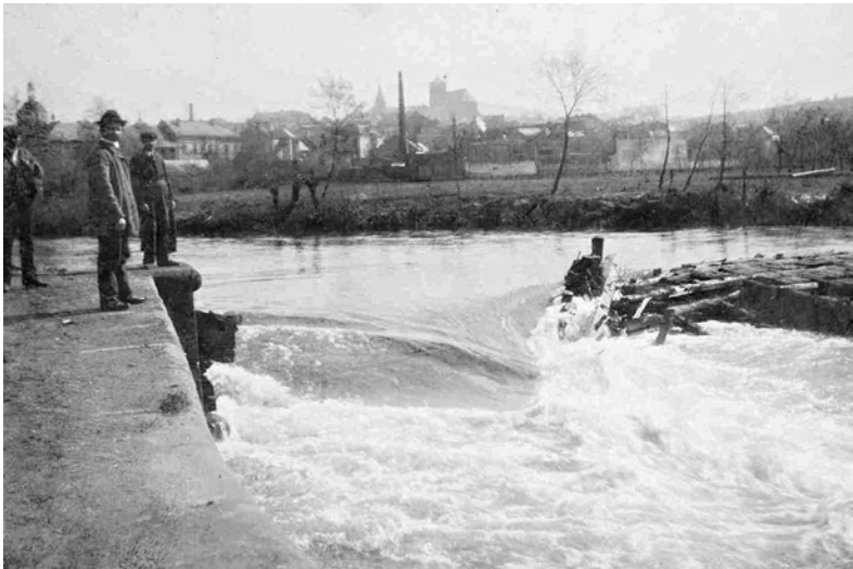
obr. 15_protřzený jez u Shořalého mlýna (dnes je tu vakový jez); zdroj: turnovskovakci.cz - článek Když Jizera hrozila
