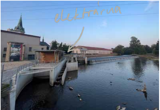
Malá vodní elektrárna Přepěře
