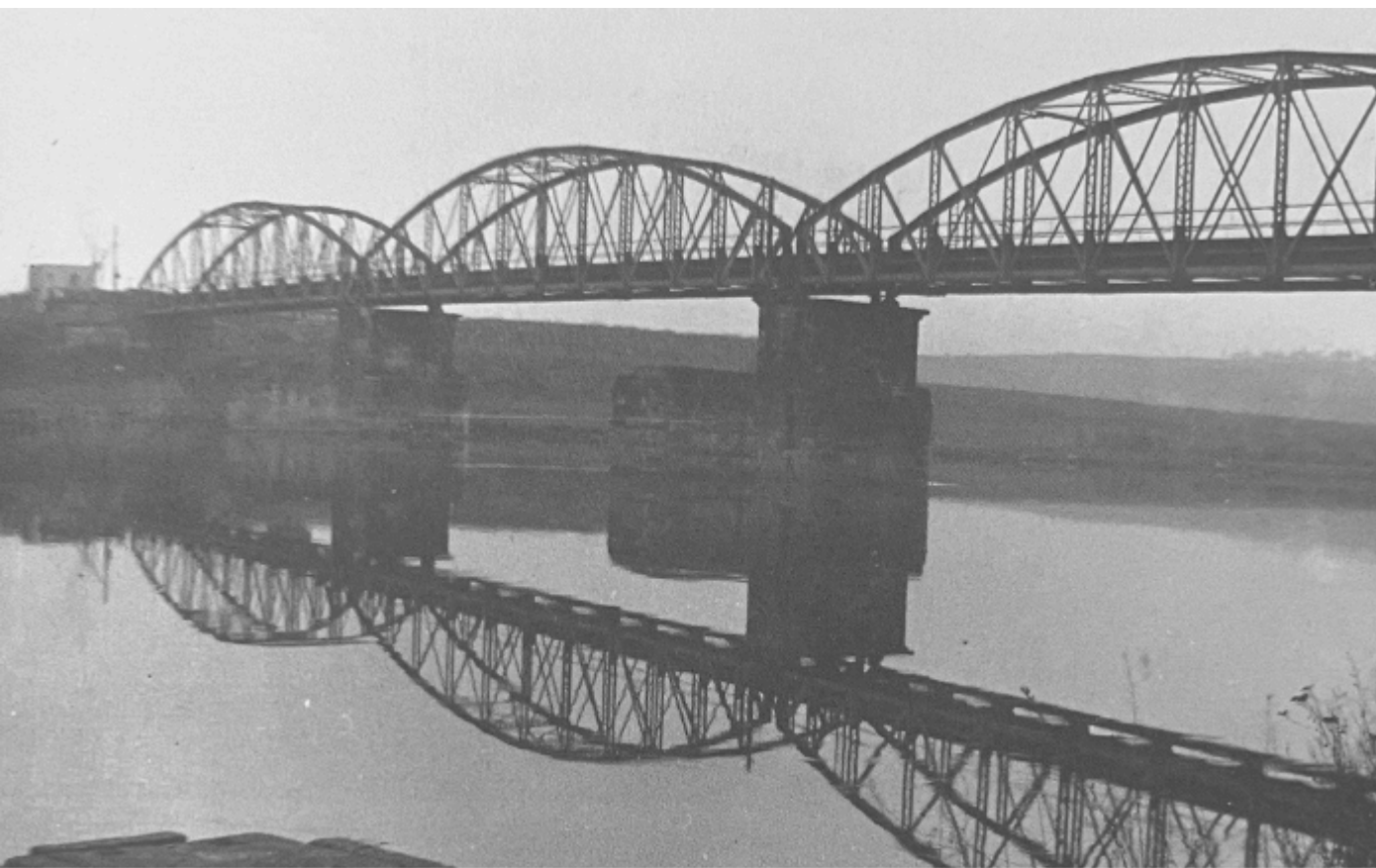
první železniční most v Kralupech, fotografie z roku 1930, pilíře mostu jsou z roku 1865, konstrukce mostu je z roku 1885 a nahradila původní konstrukci (Zmizelá tvář Kralupy)
