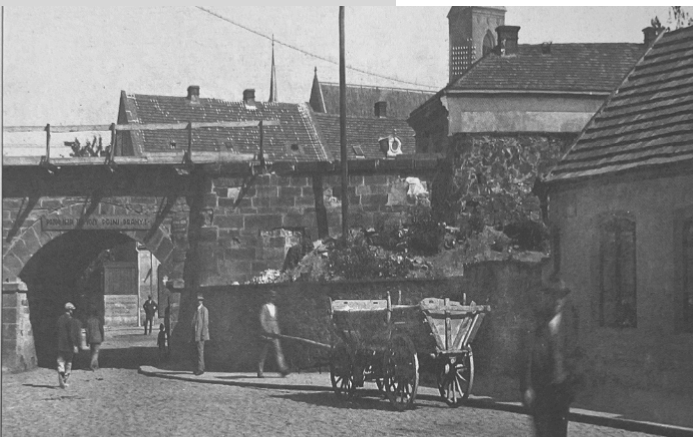
fotografie z roku 1926 kamenného viaduktu z roku 1845-50 (Zmizelá tvář Kralupy)
