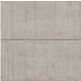
pohledový beton - strop obr.4
