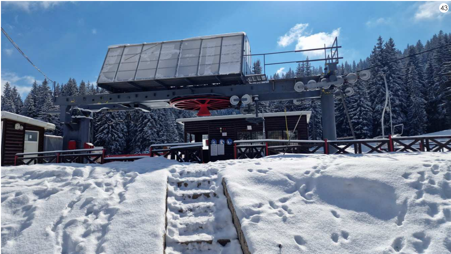
současný stav nástupní stanice lanovky (zdroj: vlastní)
