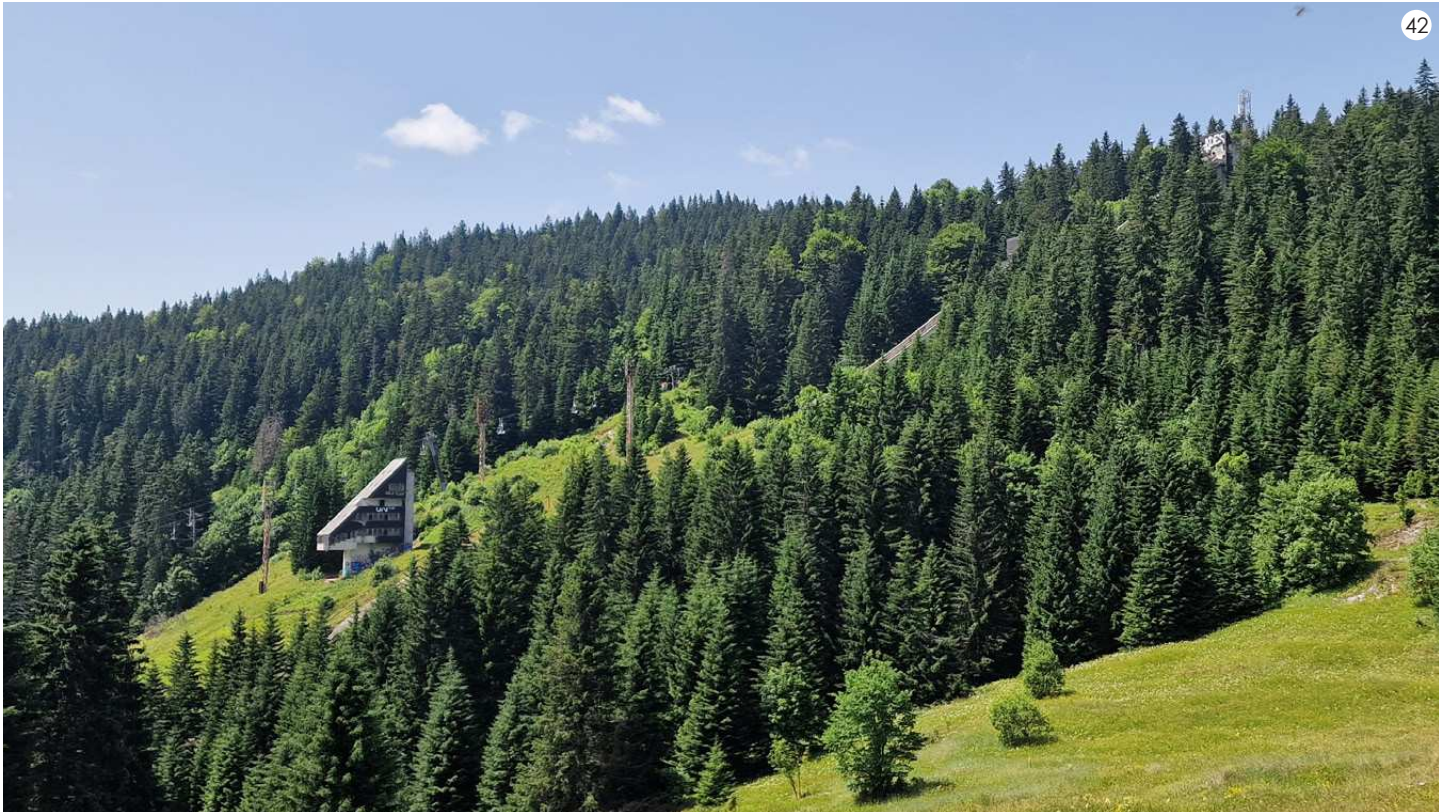
pohled na skokanské můstky ze silnice na severu (zdroj: vlastní)
