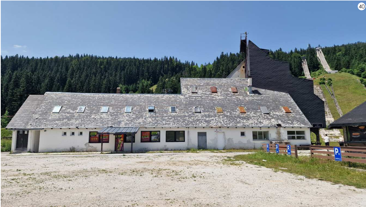
budova restaurace, částečně v provozu (zdroj: vlastní)
