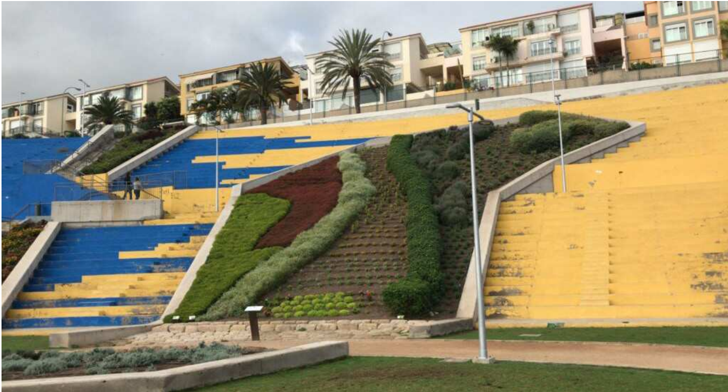
rekonstrukce betonové konstrukce tribun a jejich přizpůsobení jinému účelu, sezení a aktivace veřejného prostoru (foto: bývalý stadion Las Palmas, dnes park Parque del Estadio Insular, Španělsko; zdroj: venacanarias.com)
