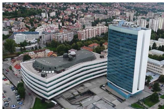
Parlament Bosny a Hercegoviny sídlo zákonodárné moci Bosny a Hercegoviny z roku 1982. (renovace 2009.) architekt: Juraj Neidhardt (zdroj: n1info.ba)
