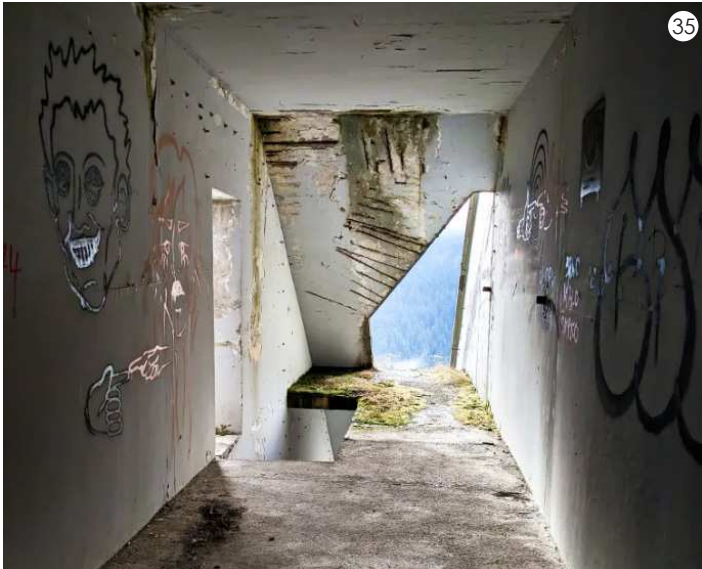
interiér skokanského můstku (zdroj: exploringwithkatie.com)
