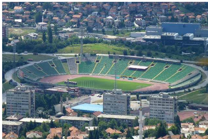
stadion Koševo, Sarajevo z roku 1947, renovace 1966 a 1983, stále v provozu architekti: Vaso Todorović & Anatolij Kirjakov (1947), Lidumil Alikalfić & Dušan Đapa (za rekonstrukci z 80. let). (zdroj: spomenikdatabase.org)
