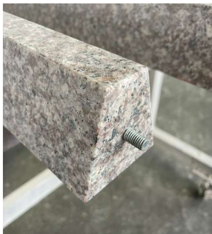
Obr. 51: spoj - závitový šroub
