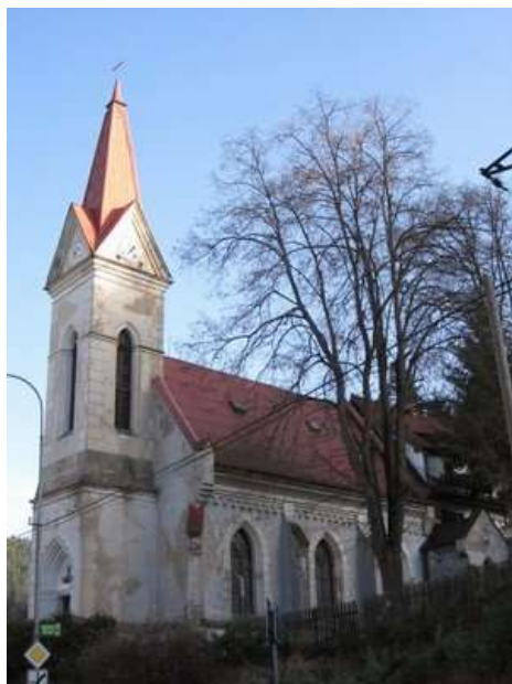
Obr. 4: kostel před opravou fasády, říjen 2011
