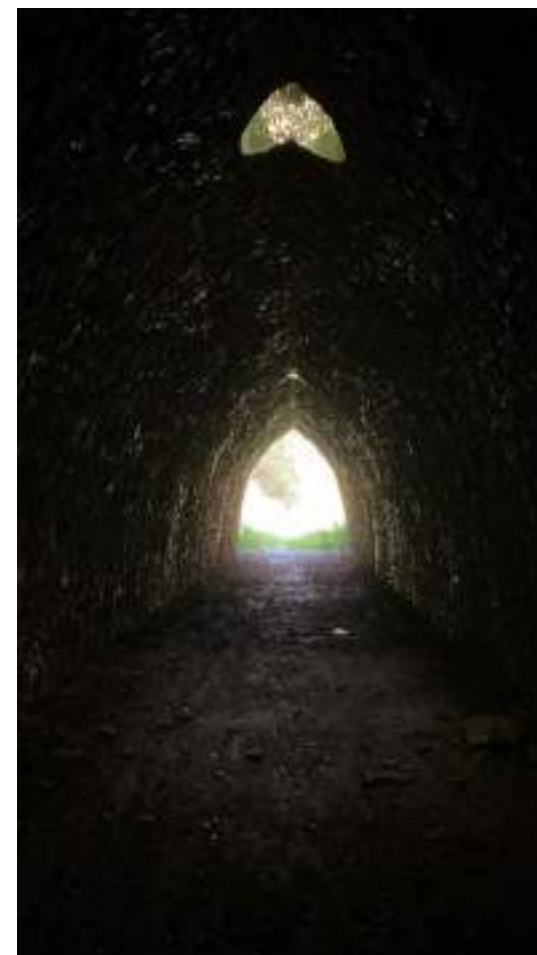
severní pohled v tunelu na světlíky
