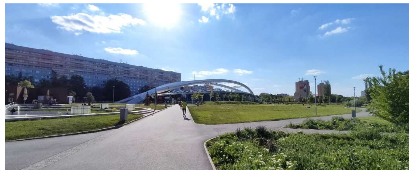
velké měřítko, stanice metra C Střížkov a nedokončená část centrálního parku
