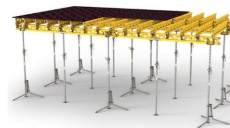
Obr. 3.3.1 Debnenie vodorovných konštrukcií PERI MULTIFLEX s nosníkmi GT24
