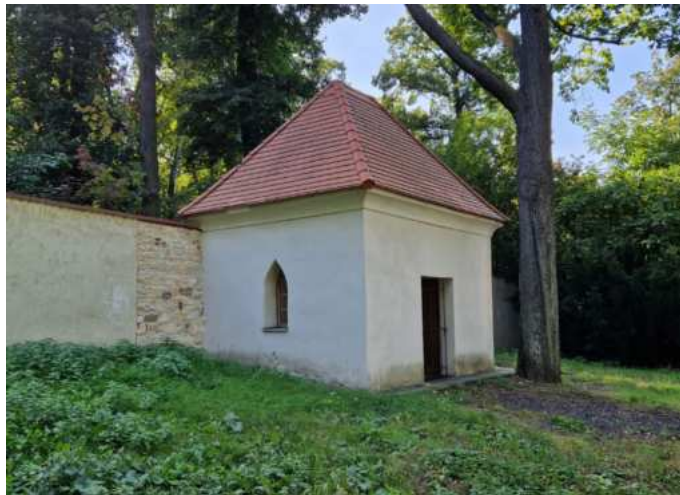
5 bývalá mírnice přilehlá na zeď Obory Hvězda
