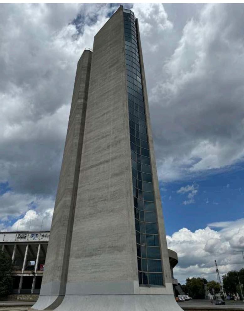
Výdechové věže Strahovského tunelu [17].
