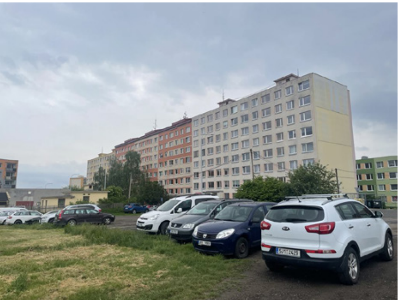
Panelový dům (8. NP) v Plešivecké ulici u navrhovaného parku Pod Strání.
