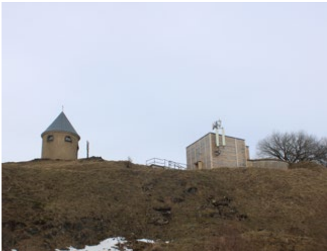
zemní vodojem na Mědníku (zdroj: autor)
