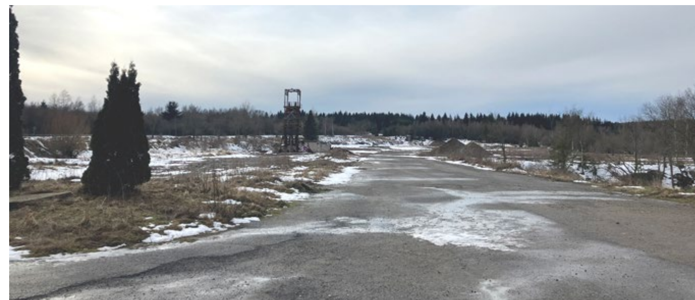
současný průhled podélnou osou areálu, 2025 (zdroj: autor)
