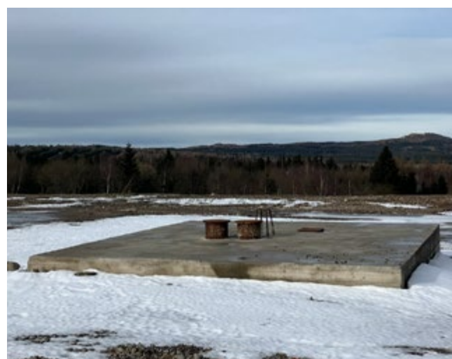
betonová zátka skipojámy, 2025 (zdroj: autor)
