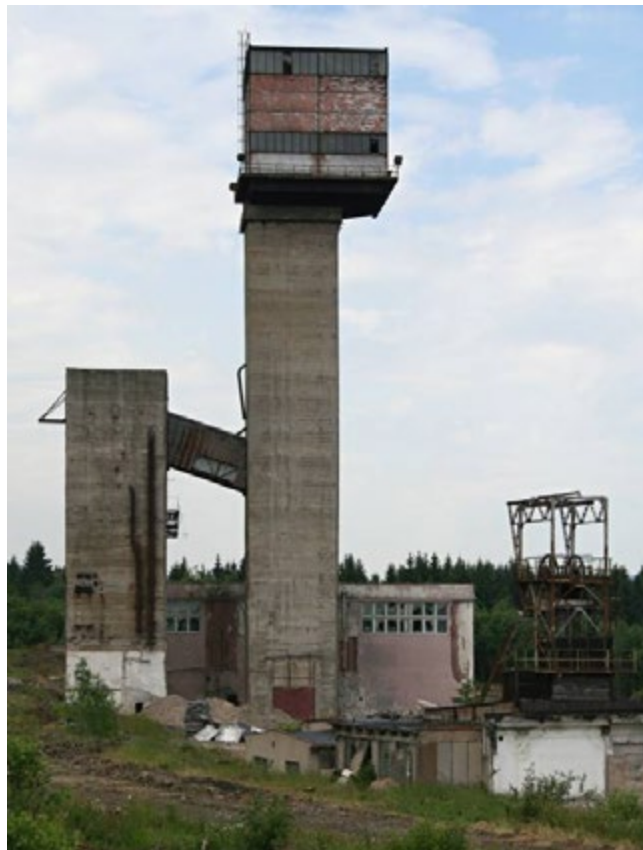
těžní skipová věž, 2022 (zdroj: NPÚ ú.o.p. Ústí nad Labem, Páral Matěj)
