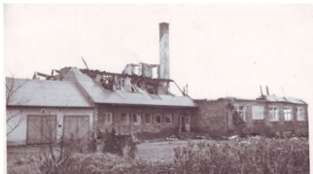
stav po požáru (zdroj: www.zanikleobce.cz)
