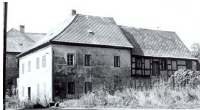
fara, pohled na zadní hrázděnou konstrukci (zdroj: archiv Petra Mikšíčka)
