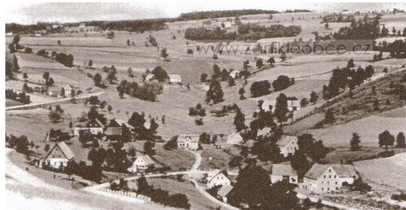
pohled od jihu do údolí potoka, v popředí serpentiny stávající silnice (zdroj: www.zanikleobce.cz )
