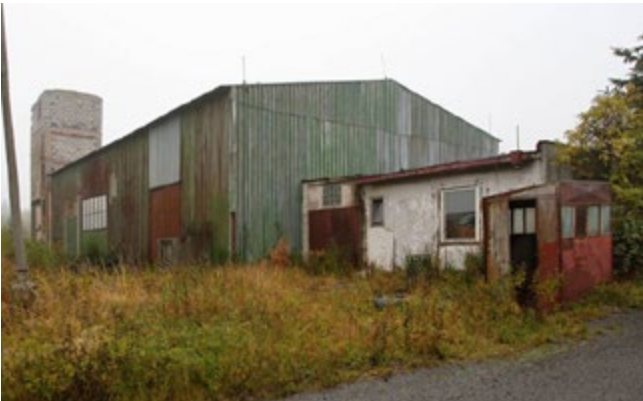
kotelna s vrátnicí, 2015 (zdroj: NPÚ ú.o.p. Ústí nad Labem, Neumannová Kateřina)
