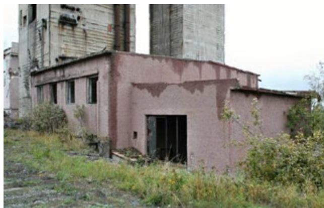
odprašovna - pohled od JV, 2020 (zdroj: NPÚ ú.o.p. Ústí nad Labem, Páral Matěj)
