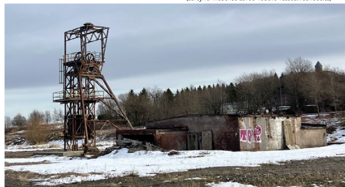
jediné zachované objekty areálu - těžní věž a strojovna, 2025 (zdroj: autor)
