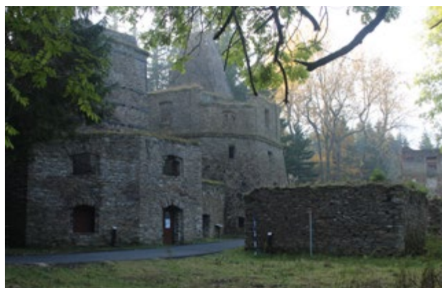
vápenka u Kovářské, přidružený objekt (zdroj: autor)
