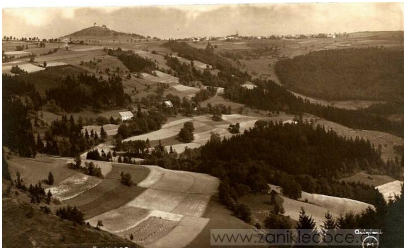
pohled od jihu do údolí potoka, v popředí serpentiny stávající silnice (zdroj: www.zanikleobce.cz )
