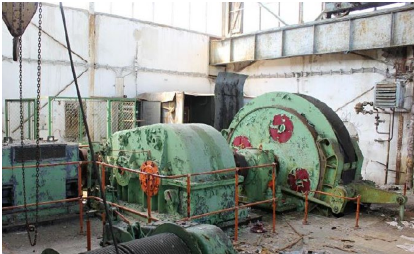
strojovna skipové věže, 2019 (zdroj: NPÚ ú.o.p. Ústí nad Labem, Hasil Petr)
