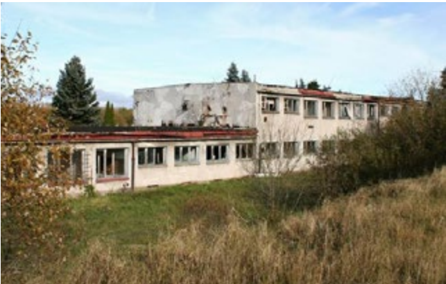
budova administrativy, v popředí oddíl šaten, 2021 (zdroj: NPÚ ú.o.p. Ústí nad Labem, Páral Matěj)
