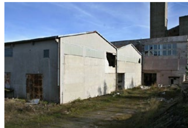
úpravná nová, pohled od JZ, 2021 (zdroj: NPÚ ú.o.p. Ústí nad Labem, Páral Matěj)
