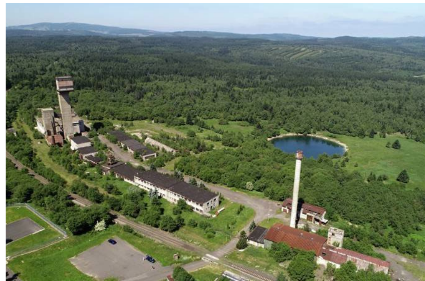
důl Měděnec, 2015 (zdroj: NPÚ ú.o.p. Ústí nad Labem, Neumannová Kateřina)
