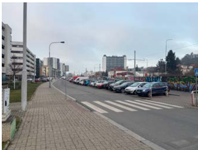
Bariéra tramvajové tratě v Modřanech
