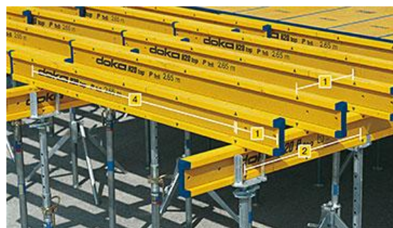
Obrázek bednění stropu, Zdroj [4]
