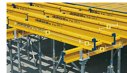
Obrázek bednění stropu, Zdroj [4]
