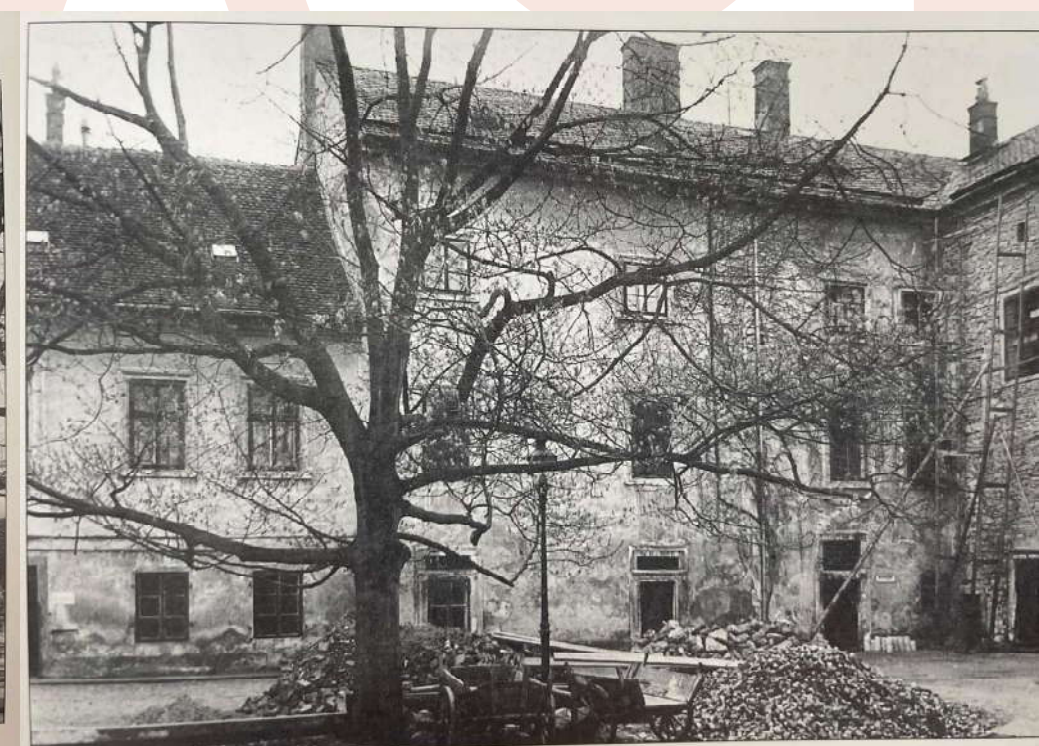
Rekonstrukce zámeckého nádvoří v roce 1940
