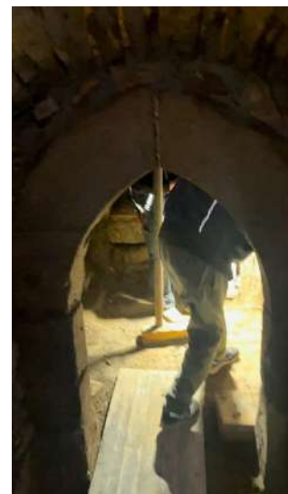
Obr. 18 a 19, podzemní chodby pod zámkem, cihlová klenba a vstup a lomený oblouk, vlastní fotografie, 4.10.2024
